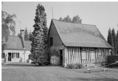
Logis et grange. Vue générale. Phot. Jean-Michel Perrin IVR22_19856000882X
