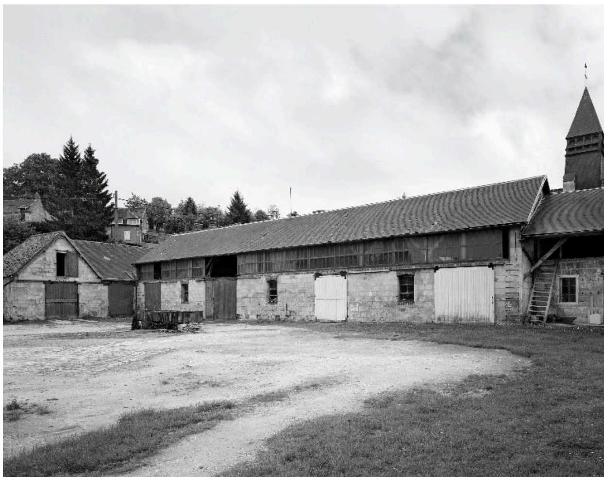
Ferme, rue du Moncet : élévation sur cour des bâtiments sud.
