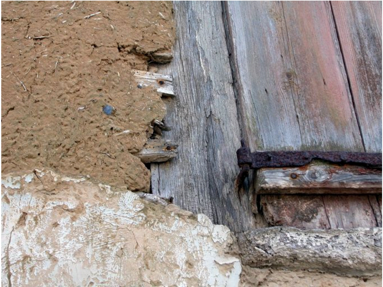
Détail des matériaux de construction.
