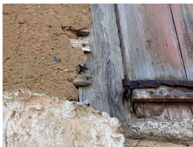
Détail des matériaux de construction. Phot. Elisabeth Justome IVR22_20048001677NUCA
