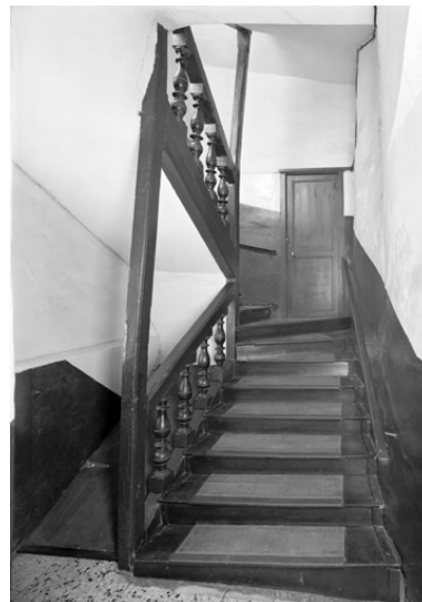
Départ de l'escalier rampe sur rampe. Phot. Thierry Lefébure IVR22_19950200392P
