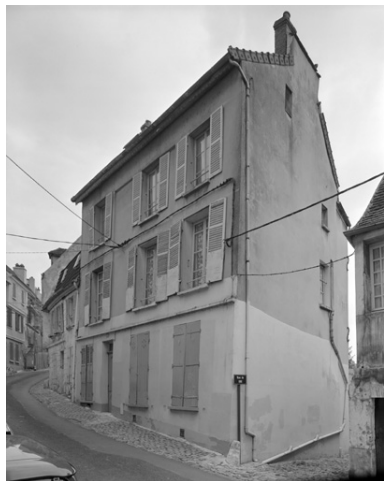
Vue d'ensemble depuis la rue. Phot. Olivier Coquelle IVR22_19940201134V
