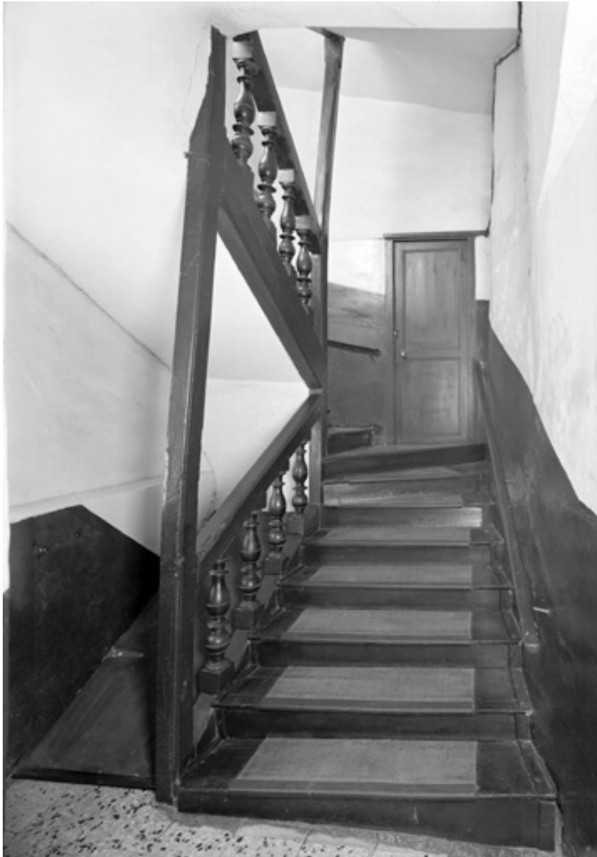
Départ de l'escalier rampe sur rampe.
