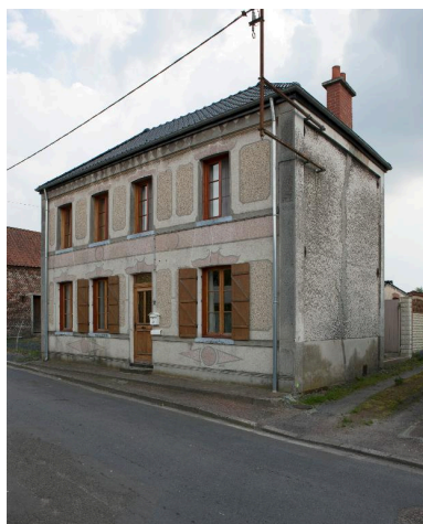
Maison 12 rue du Cimetière. Phot. Pierre Thibaut IVR31_20125901752NUCA
