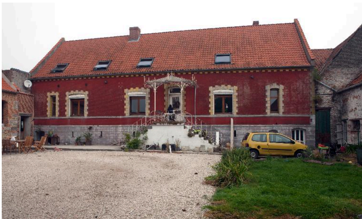
Ferme de Locron ; vue générale du logis depuis la cour.
