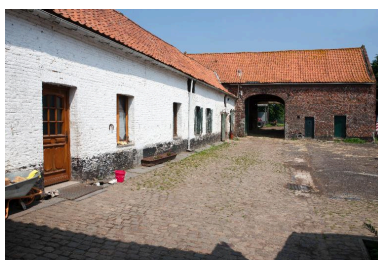
Ferme 10 Grande Rue ; vue générale de la cour : le logis, la grange et la cour pavée. Phot. Pierre Thibaut IVR31_20125901770NUCA
