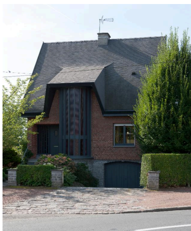
Maison datant des années 1970 (?). Phot. Pierre Thibaut IVR31_20125902170NUCA
