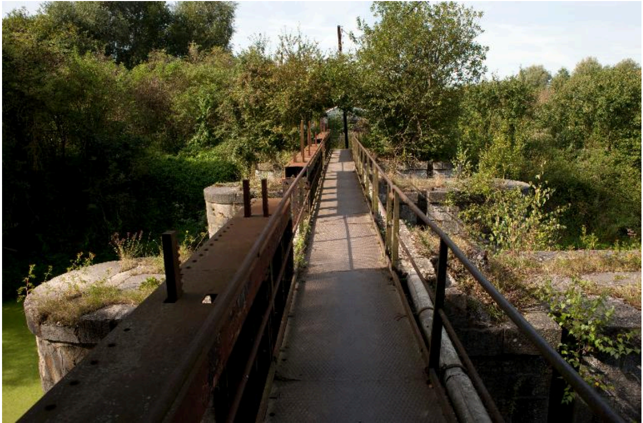
Vue générale de l'écluse de Rodignies.
