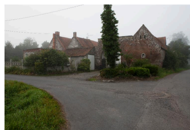
Ferme des Coriaux rue du Petit Marais. Phot. Pierre Thibaut IVR31_20125902137NUCA
