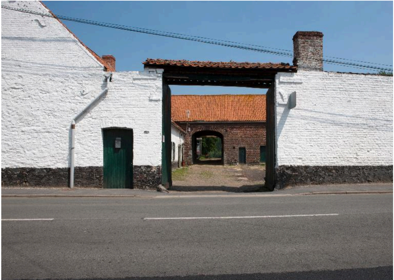
Ferme 10 Grande Rue ; vue en enfilade des passages ; le porche et les passages de la grange.
