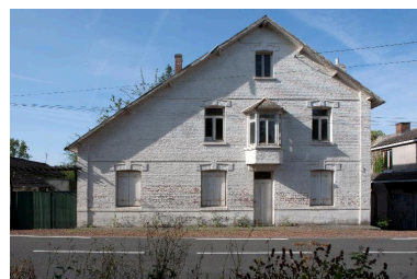
Maison 8 rue du Buridon. Phot. Pierre Thibaut IVR31_20125902169NUCA
