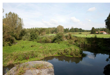
Le bief (?) de l'écluse de Rodignies. Phot. Pierre Thibaut IVR31_20125902173NUCA
