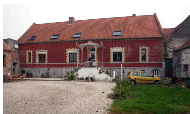
Ferme de Locron ; vue générale du logis depuis la cour. Phot. Pierre Thibaut IVR31_20125902147NUCA
