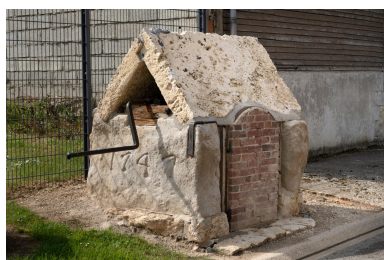
Puits en pierre rue des Hayes portant la date de 1747, vue depuis le nord-est. Phot. Marc Kérignard IVR32_20226000331NUCA
