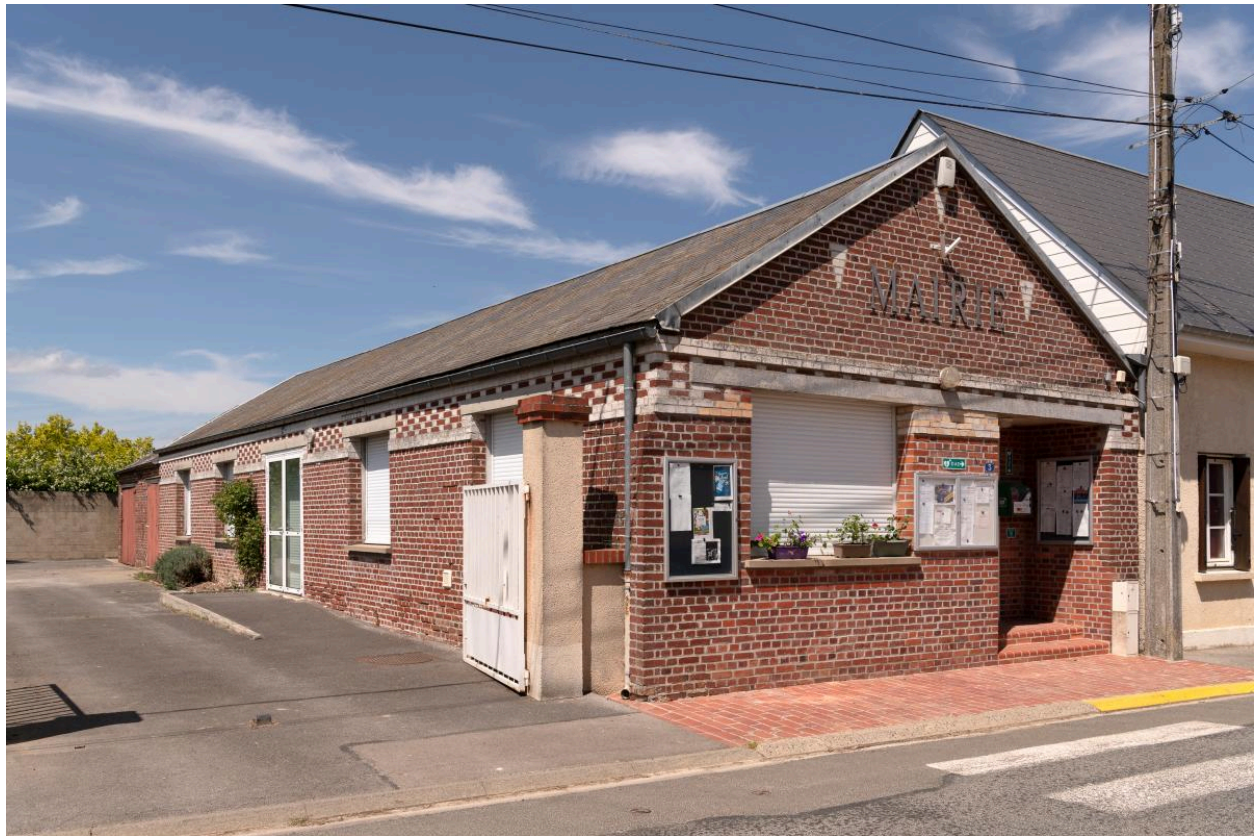
Mairie, rue des Hayes, vue depuis le sud.
