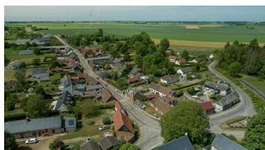
Vue aérienne de la rue Notre-Dame depuis le sud-est. Phot. Marc Kérignard IVR32_20226000390NUCA
