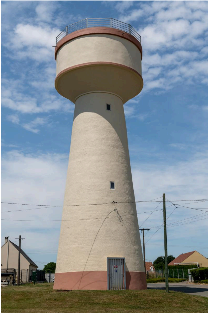
Château d'eau à l'emplacement d'un ancien manoir seigneurial, rue Saint-Nicolas.
