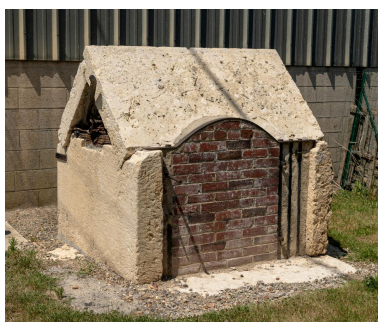
Ancien puits rue Notre- Dame, vue depuis le sud-est. Phot. Marc Kérignard IVR32_20226000606NUCA
