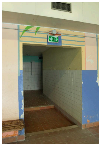
Pédiluve d'accès au bassin.
