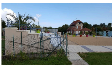
Gradins de l'ancienne piscine. Phot. Laurence Schlosser IVR32_20178005334NUCA
