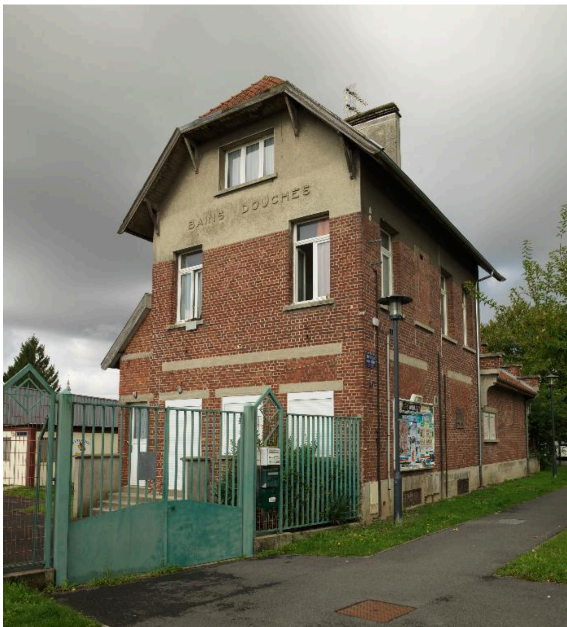
Bâtiment des bains-douches.
