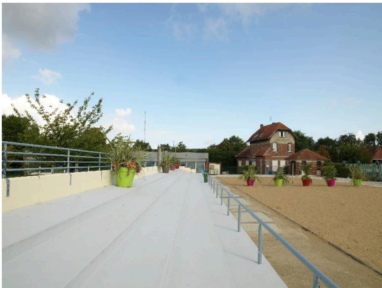
Gradins de l'ancienne piscine découverte.
