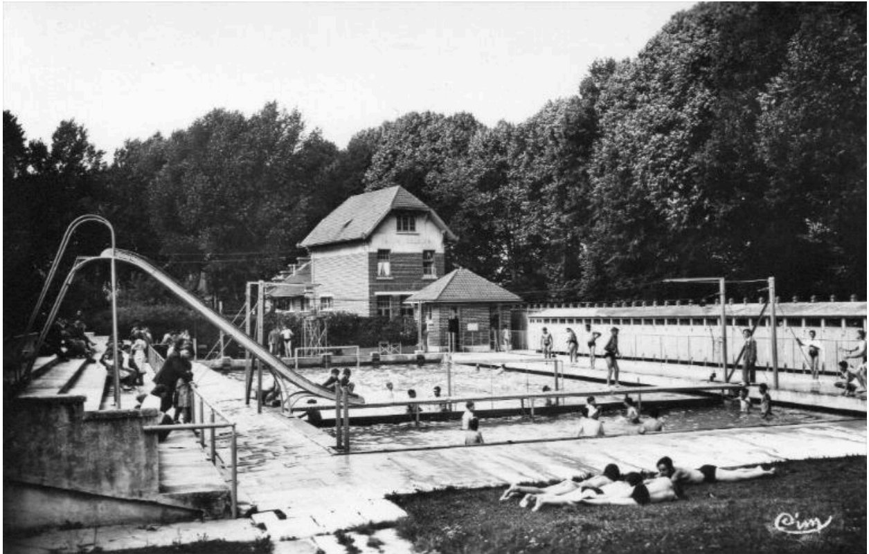
Vue d'ensemble de la piscine extérieure de Doullens (avec les gradins, les cabines, le toboggan, la passerelle, l'appareil à suspension pour l'apprentissage de la natation, et dans le fond : le pavillon d'entrée et les bains-douches), carte postale, vers 1950 (coll. part.).
