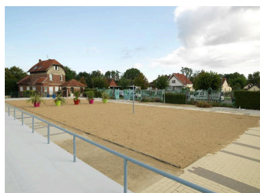
Vue générale de l'emplacement de l'ancienne piscine découverte (aujourd'hui remplie de sable). Phot. Marie-Laure Monnehay-Vulliet IVR32_20178000451NUC2A
