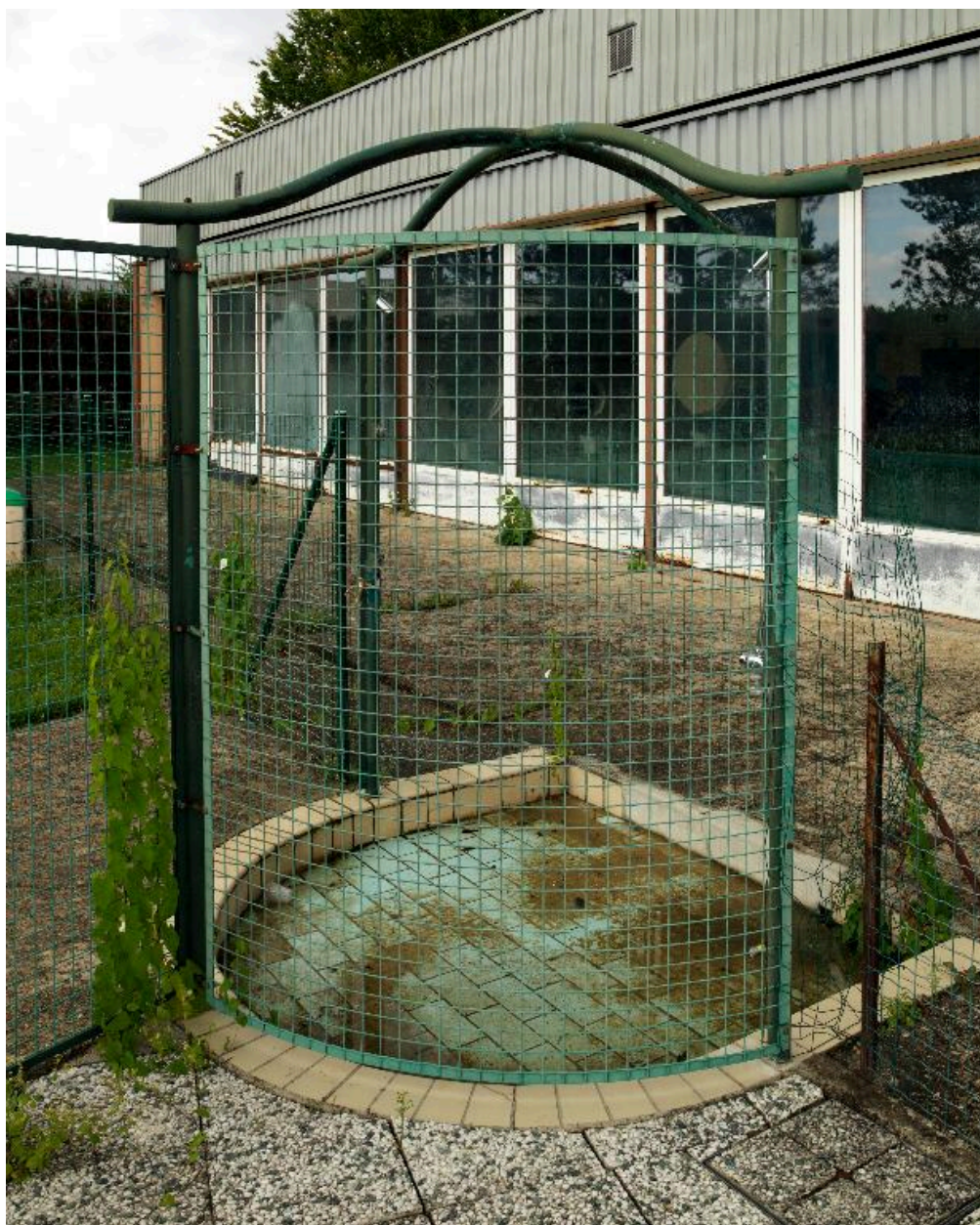
Douche-pédiluve, qui permettait de joindre la piscine Plein Soleil au bassin extérieur.
