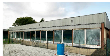
Façade sud et terrasse-solarium. Phot. Marie-Laure Monnehay-Vulliet IVR32_20178000448NUC2A
