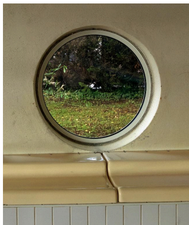
Détail d'une des ouvertures en forme de hublot. Phot. Marie-Laure Monnehay-Vulliet IVR32_20178000427NUC2A
