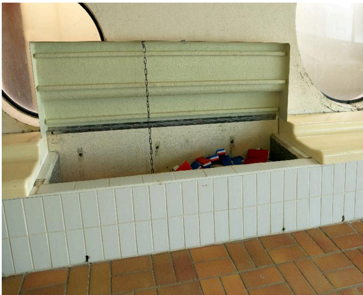
Détail des bancs aménagés le long des murs-pignons, qui servent également de rangement.
