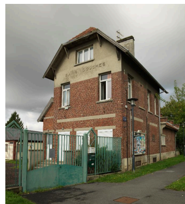
Bâtiment des bains-douches. Phot. Marie-Laure Monnehay-Vulliet IVR32_20178000446NUC2A
