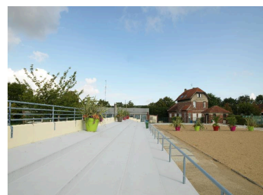
Gradins de l'ancienne piscine découverte. Phot. Marie-Laure Monnehay-Vulliet IVR32_20178000452NUC2A
