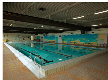
Vue générale du bassin de natation et des poutres de translation permettant l'ouverture de la toiture.
