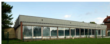
Façade sud vitrée de la piscine Plein Soleil. Phot. Marie-Laure Monnehay-Vulliet IVR32_20178000450NUC2A
