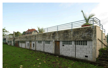
Gradins de l'ancienne piscine découverte, qui abritaient la machinerie et des vestiaires. Phot. Marie-Laure Monnehay-Vulliet IVR32_20178000454NUC2A
