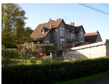
Maison à deux unités d'habitation. Phot. Isabelle Barbedor IVR22_20048010460NUCA
