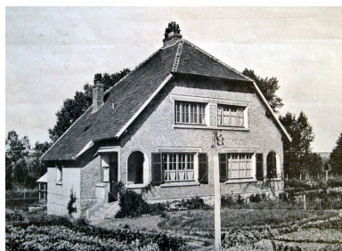
Cité de la Canardière (pl. 27). La construction Moderne, n° 7, 14 novembre 1926. Phot. Isabelle Barbedor IVR22_20048010757NUCA
