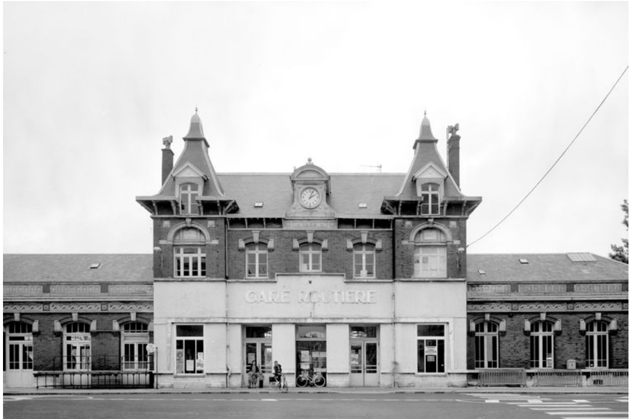
L'ancienne gare de Berck-Plage, vue prise en 1981.
