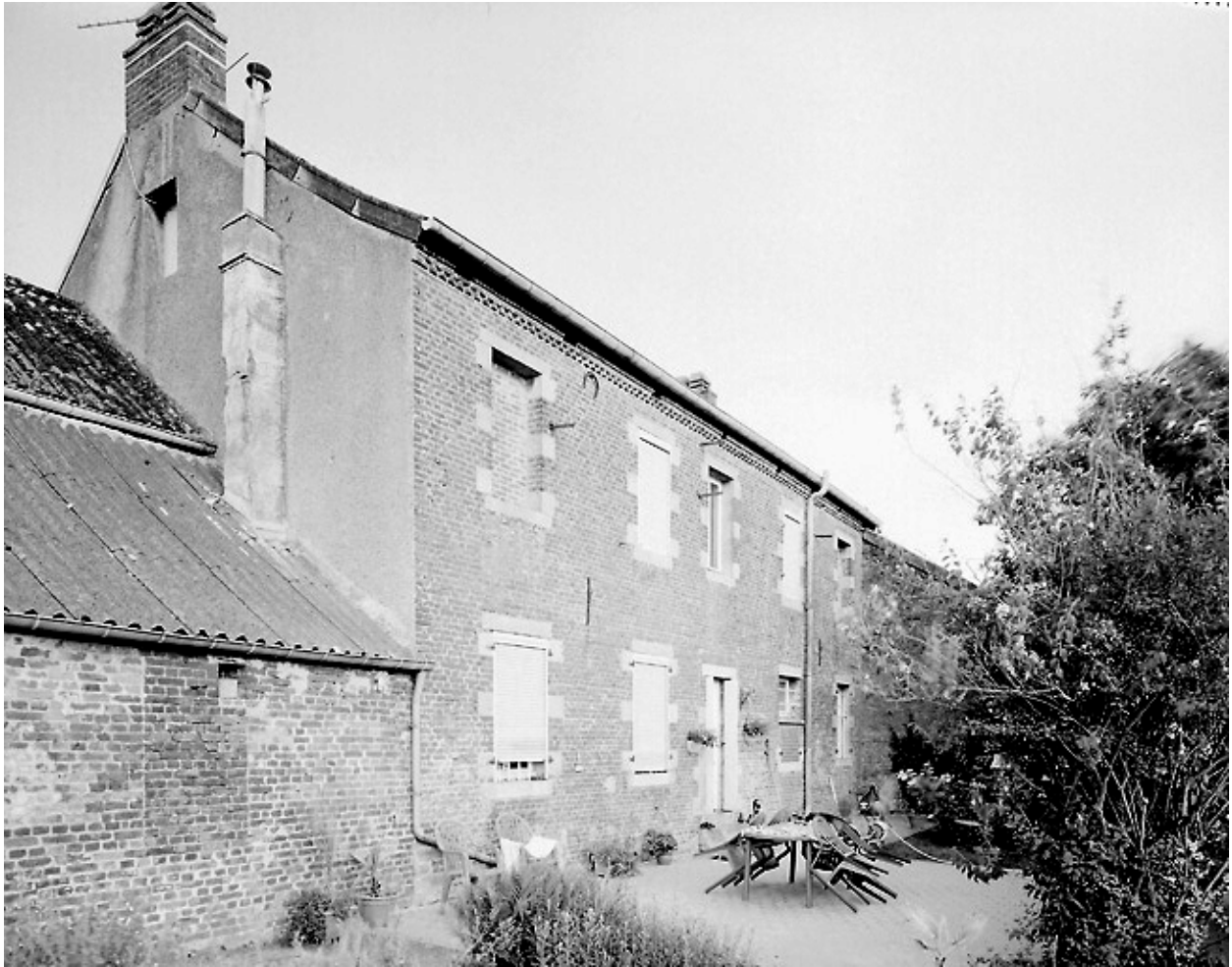
Vue de l'élévation postérieure du logis.
