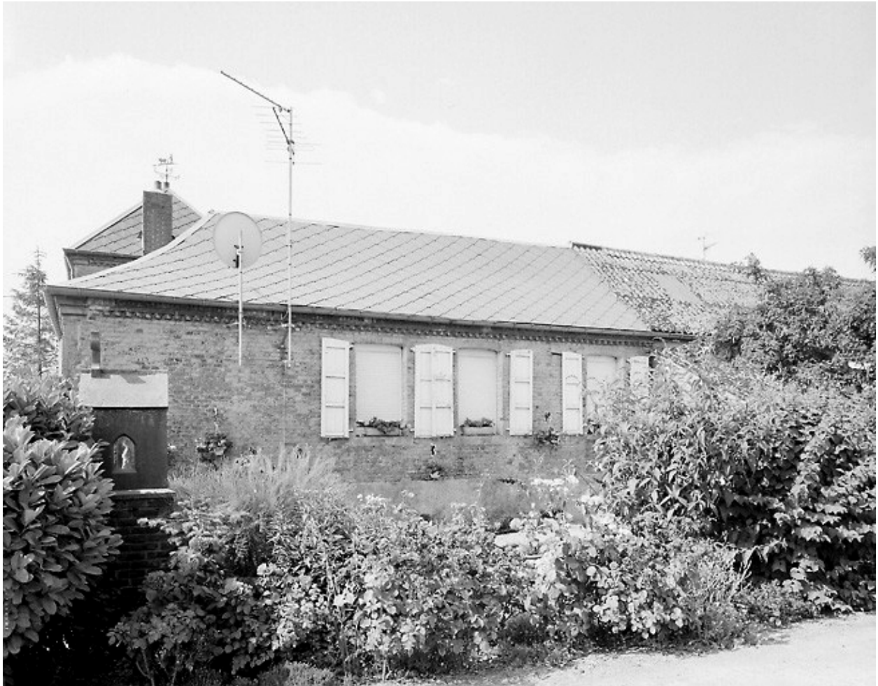
Vue de l'élévation postérieure de l'aile nord et de l'oratoire situé le long de la nationale.
