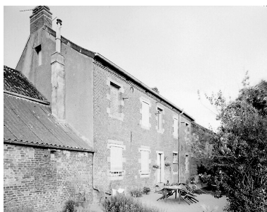
Vue de l'élévation postérieure du logis. Phot. Pierre Thibaut IVR31_20055900636V
