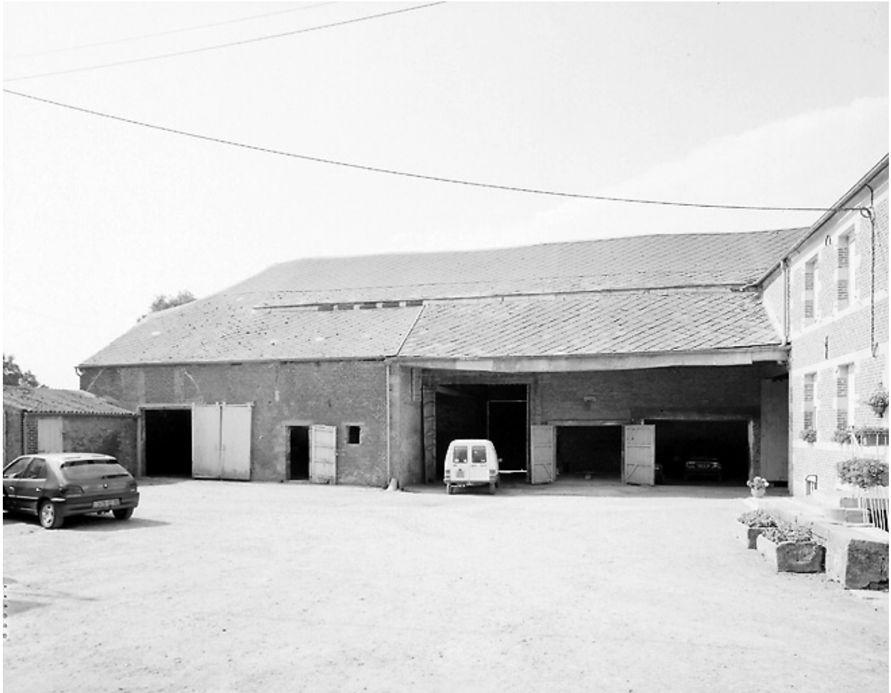
Vue des bâtiments d'exploitation de l'aile sud.
