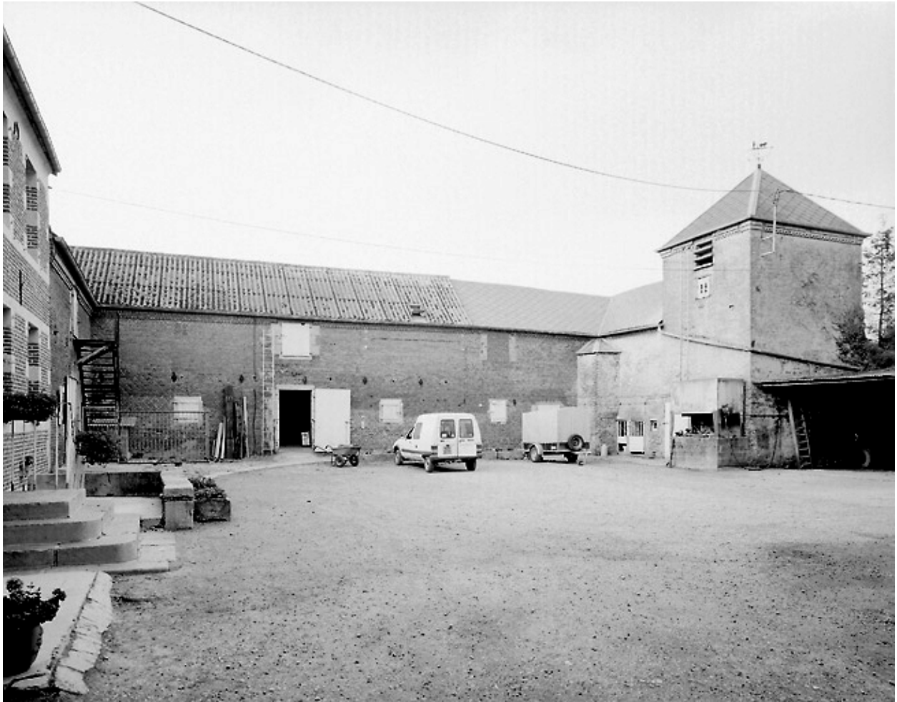
Vue des bâtiments d'exploitation de l'aile nord et du pigeonnier.
