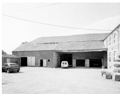
Vue des bâtiments d'exploitation de l'aile sud. Phot. Pierre Thibaut IVR31_20055900638V
