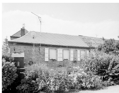
Vue de l'élévation postérieure de l'aile nord et de l'oratoire situé le long de la nationale.
