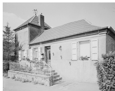
Vue de l'élévation postérieure du logement indépendant situé à l'est. Phot. Pierre Thibaut IVR31_20055900648V
