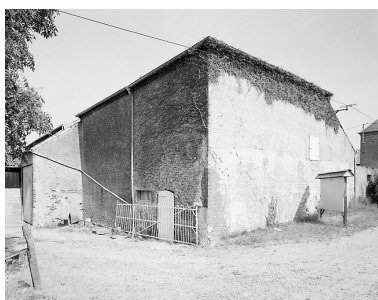
Vue de l'élévation postérieure des bâtiments d'exploitation de l'aile sud. Phot. Pierre Thibaut
