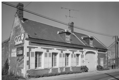
Logis. Elévation sur rue. Phot. Jean-Michel Perrin IVR22_19856001005X
