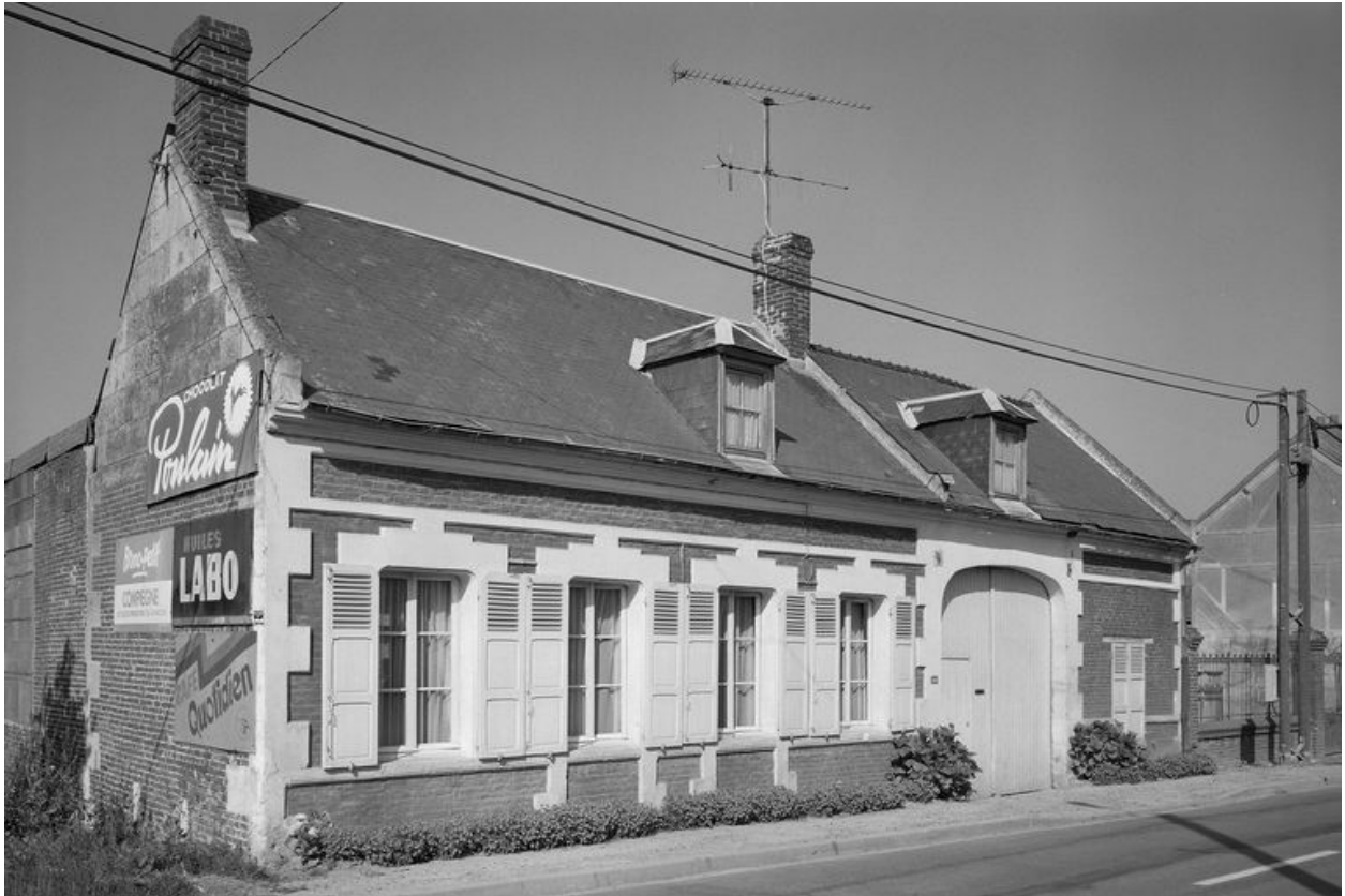
Logis. Elévation sur rue.
