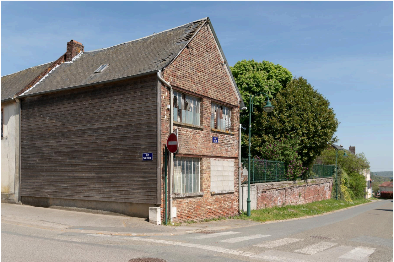
Ancienne fabrique de boutons de nacre, rue Saint-Pierre, vue prise depuis l'ouest.
