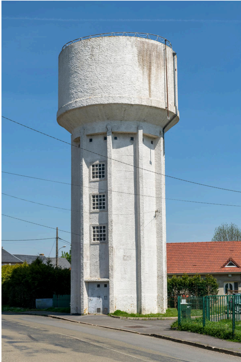
Château d'eau, rue de la Grand Cour.
