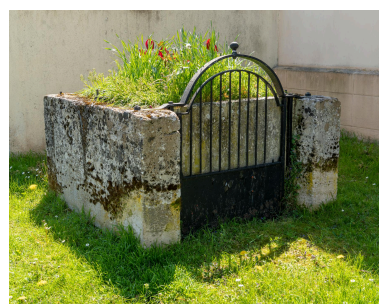
Ancien puits de la rue du Frêne. Phot. Marc Kérignard IVR32_20236000560NUCA
