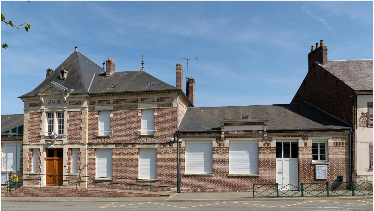
Ancien groupe scolaire et mairie ("1913"), n°5 de la rue Saint-Pierre, vue prise depuis l'ouest.
