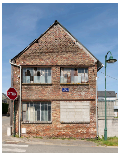
Mur-pignon de l'ancienne fabrique de boutons de nacre, vue prise depuis le sud. Phot. Marc Kérignard IVR32_20236000567NUCA
