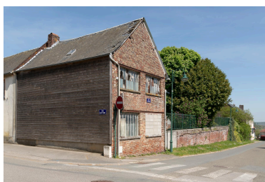
Ancienne fabrique de boutons de nacre, rue Saint-Pierre, vue prise depuis l'ouest. Phot. Marc Kérignard IVR32_20236000566NUCA
