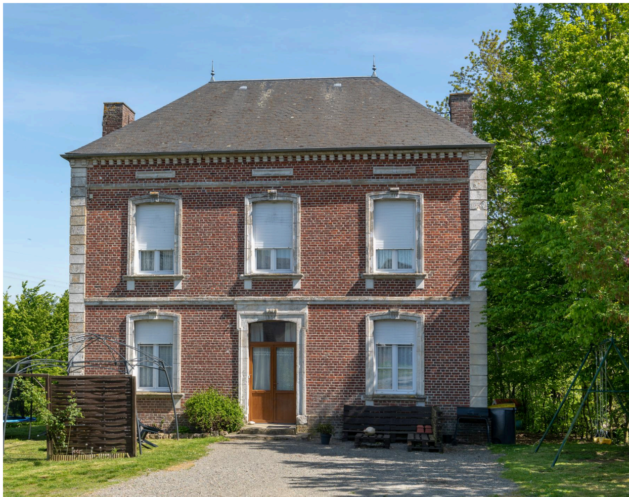
Ancien presbytère, n°8 rue du Presbytère, vue prise depuis l'ouest.
