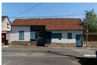
Maison de serger, n°15 de la rue des Jardins, vue prise depuis l'ouest. Phot. Marc Kérignard IVR32_20236000551NUCA
