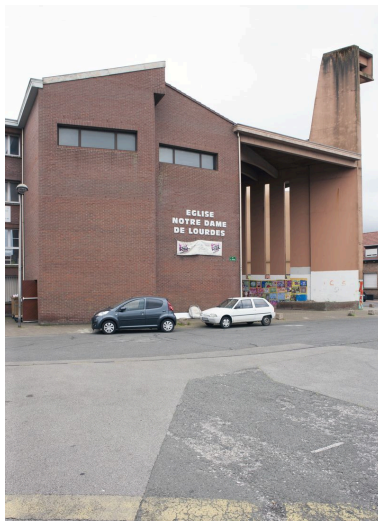
Vue de trois quart gauche de l'ancienne église. Phot. Pierre Thibaut IVR31_20155900913NUCA
