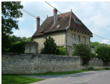
Vue antérieure de la maison. Phot. Irwin Leullier IVR22_20030203266NUCA
