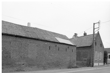
Vue d'ensemble des élévations sud-est, sur rue. Phot. Thierry Lefébure IVR22_19920201304Z
