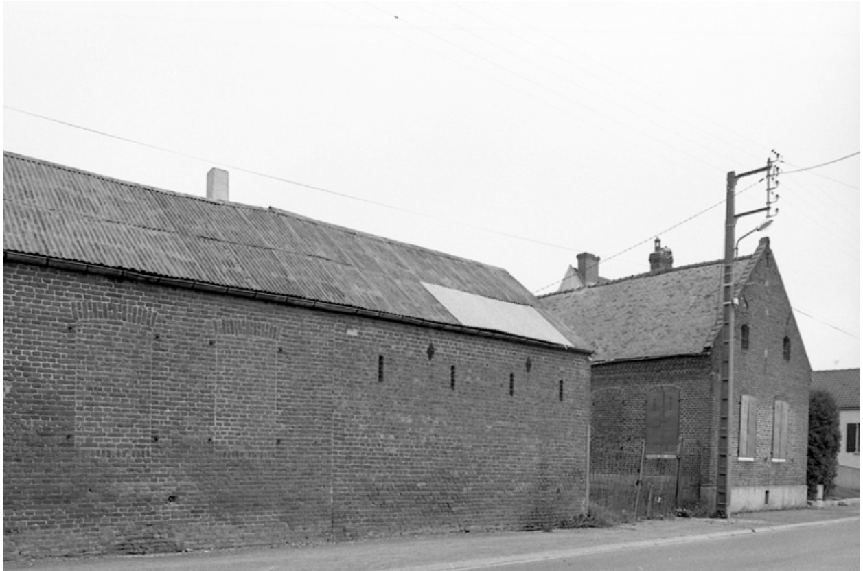
Vue d'ensemble des élévations sud-est, sur rue.
