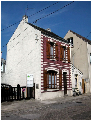
Vue d'ensemble et de trois-quarts. Phot. Elisabeth Justome IVR22_20058002802NUCA
