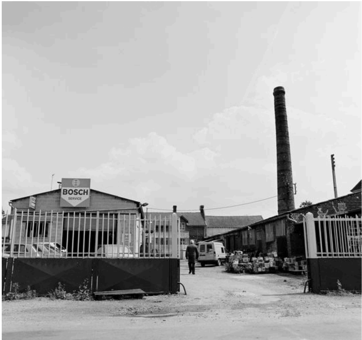
Vue générale, avec à droite l'ancien atelier de fabrication et la cheminée d'usine.
