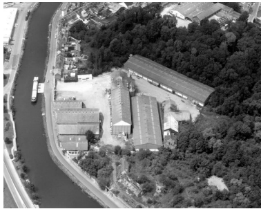
Vue aérienne, flanc est. Phot. Phot'R IVR22_19908001699P
