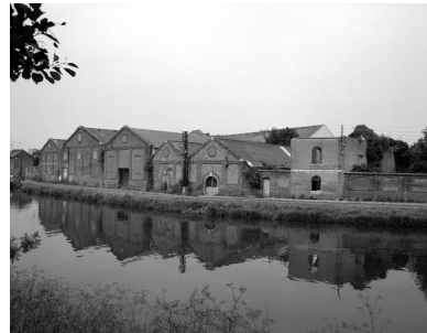
Vue partielle depuis le sud. Phot. Thierry Lefébure IVR22_19898000193X
