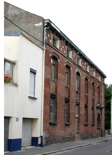
Vue prise depuis l'angle des rues Renan et Pasteur. Phot. Frédéric Pillet IVR22_20050206188NUCA
