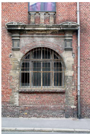
Façade antérieure : traitement des allèges des baies du premier étage. Phot. Frédéric Pillet
