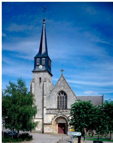
Façade occidentale. Phot. Irwin Leullier IVR22_19988000729VA
