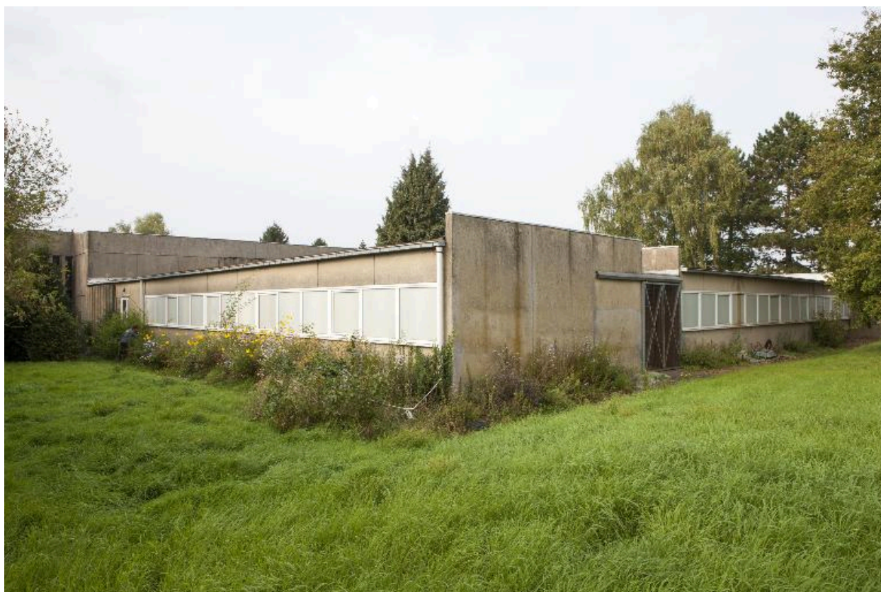
Vue arrière et latérale des salles paroissiales.
