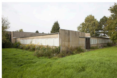
Vue arrière et latérale des salles paroissiales. Phot. Pierre Thibaut IVR31_20155900187NUCA
