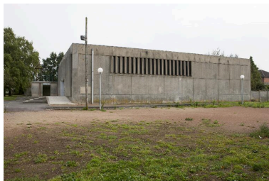
Côté droit de l'église. Phot. Pierre Thibaut IVR31_20155900188NUCA
