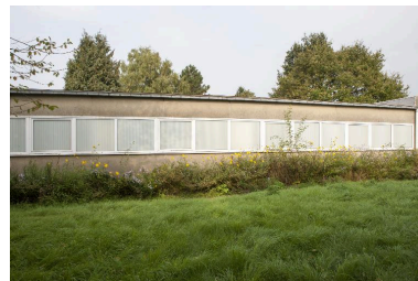
Vue des salles paroissiales à l'arrière de l'église. Phot. Pierre Thibaut IVR31_20155900186NUCA
