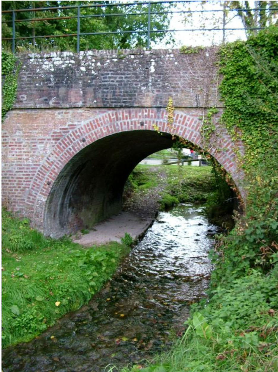
Canaples. Le pont ferroviaire franchissant la Fieffes au lieu-dit les Chanvrières de Rhin.
