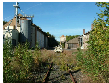
Canaples. Les bâtiments de stockage du Réveil agricole de Picardie de part et d'autre de la voie ferrée. Phot. Frédéric Fournis IVR22_20098005446NUCA
