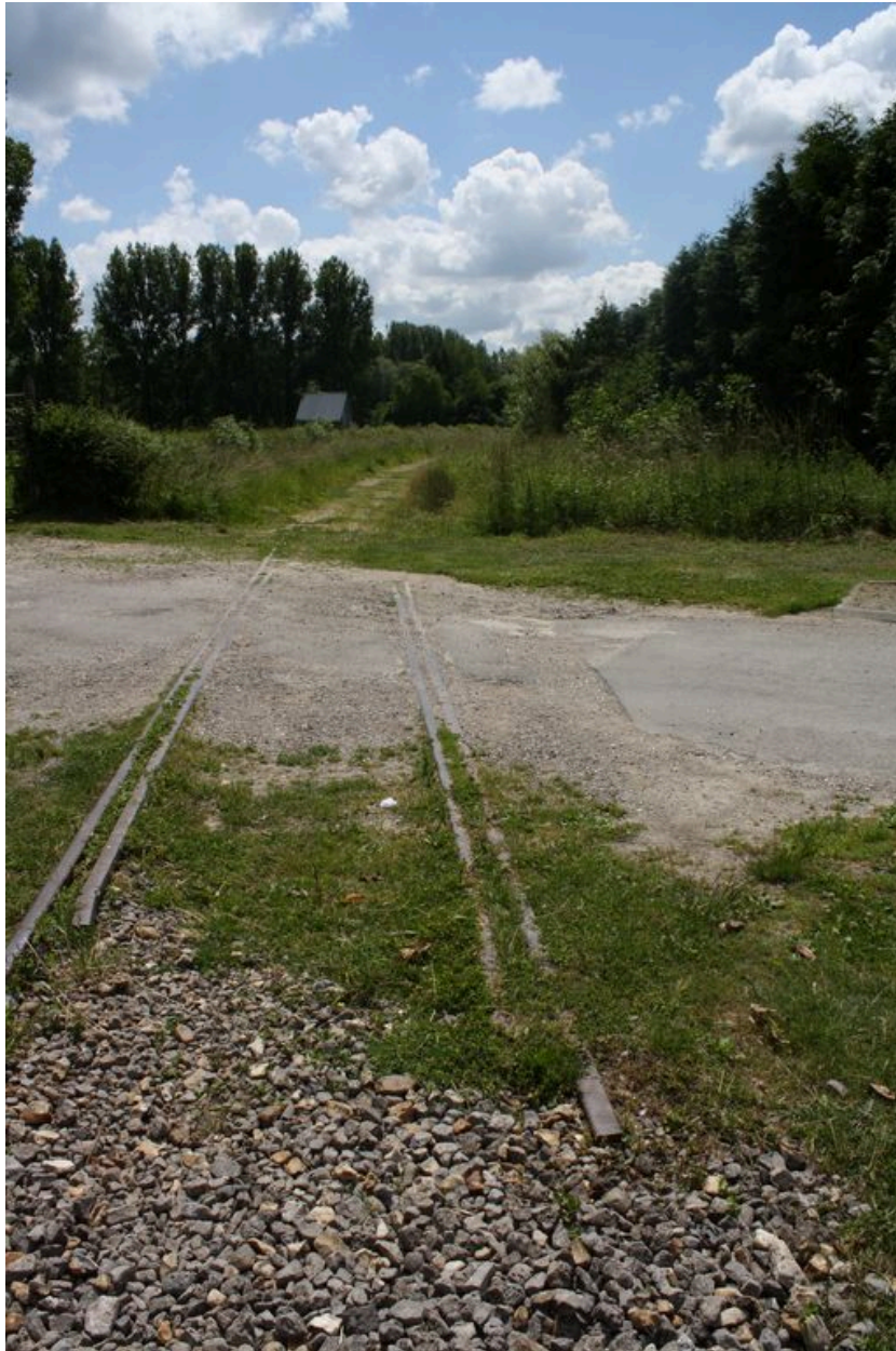
L'ancienne ligne ferroviaire Frévent-Gamaches à Ville-le-Marcelet.
