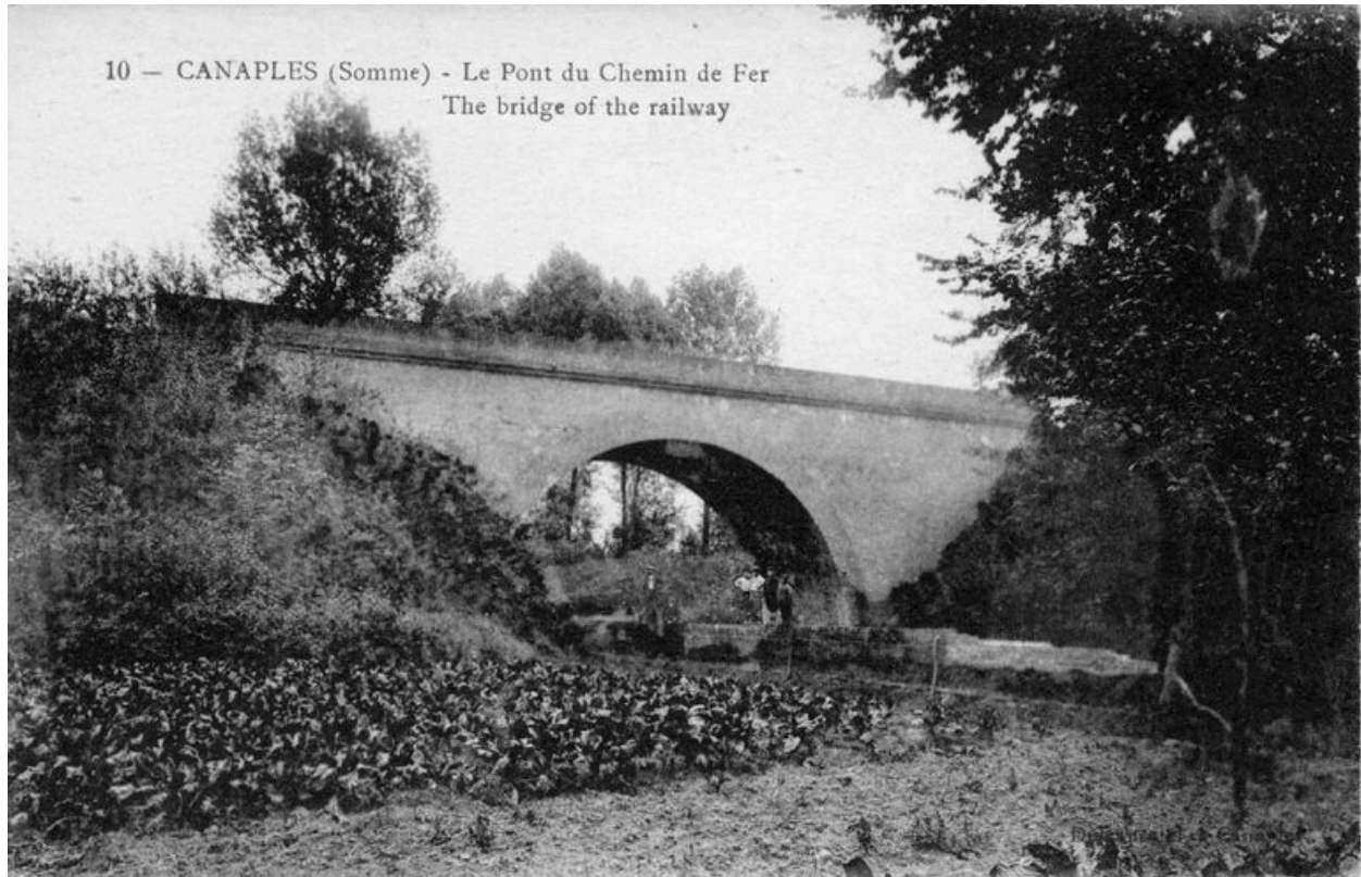
Canaples. Le pont ferroviaire franchissant la Nièvre, 1er quart du 20e siècle (coll. part.).
