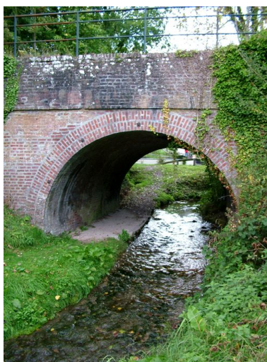
Canaples. Le pont ferroviaire franchissant la Fieffes au lieu-dit les Chanvrières de Rhin. Phot. Frédéric Fournis IVR22_20098005542NUCA
