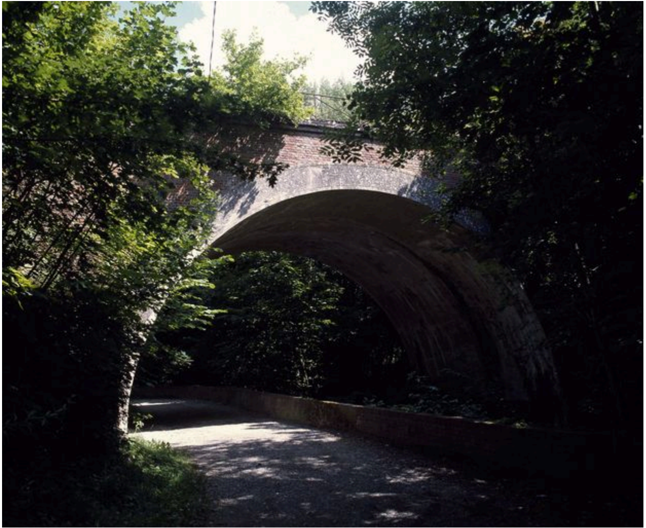
Canaples. Le pont ferroviaire de la ligne Amiens-Doullens traversant la Nièvre.
