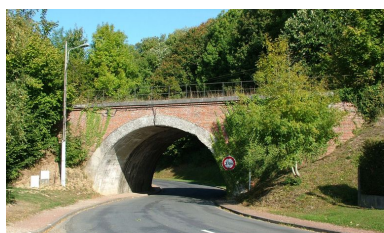
Canaples. Le pont ferroviaire de la ligne Amiens-Doullens depuis la route de Halloy-lès-Pernois à l'ouest. Phot. Frédéric Fournis IVR22_20098005448NUCA
