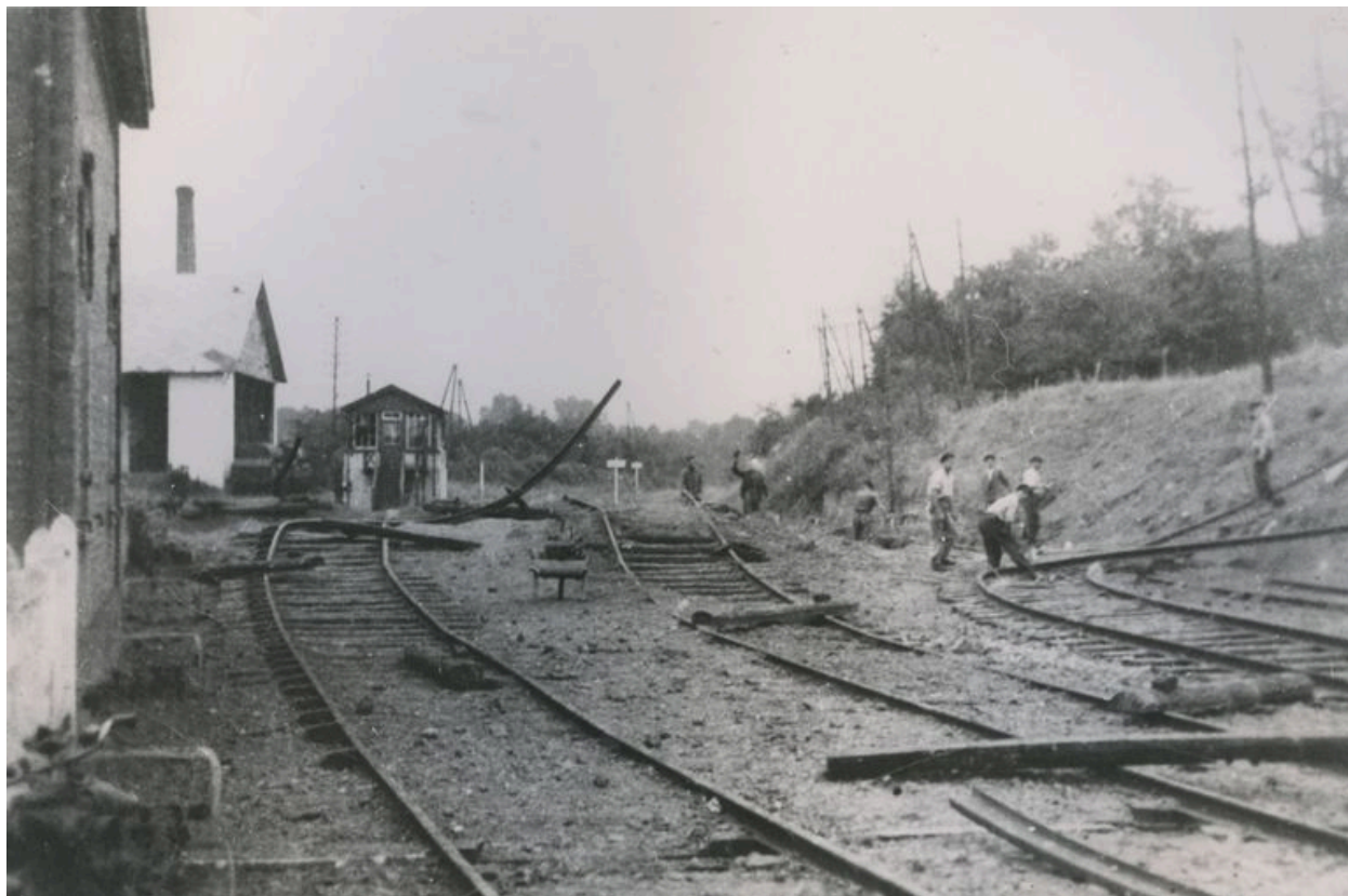
Canaples. Voies ferrées endommagées par le bombardement du 31 juillet 1944, à proximité de la maison du garde-barrière et de la laiterie (coll. part.).
