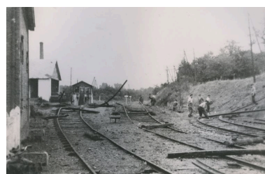
Canaples. Voies ferrées endommagées par le bombardement du 31 juillet 1944, à proximité de la maison du garde-barrière et de la laiterie (coll. part.). Phot. Monnehay-Vulliet Marie-Laure IVR22_20098000349NUCA
