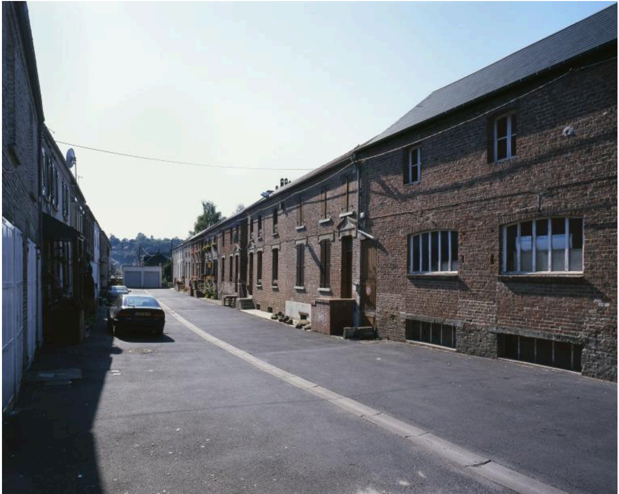
Vue de l'enfilade nord des bâtiments de l'impasse Chassagne construite en 1921.
