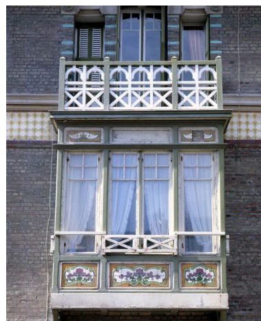
Détail d'un bow-window de l'étage carré. Phot. Marie-Laure Monnehay-Vulliet IVR22_20048000162XA
