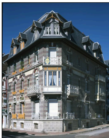
Vue d'ensemble, en cours de rénovation en 2004. Phot. Marie-Laure Monnehay-Vulliet IVR22_20048000153VA
