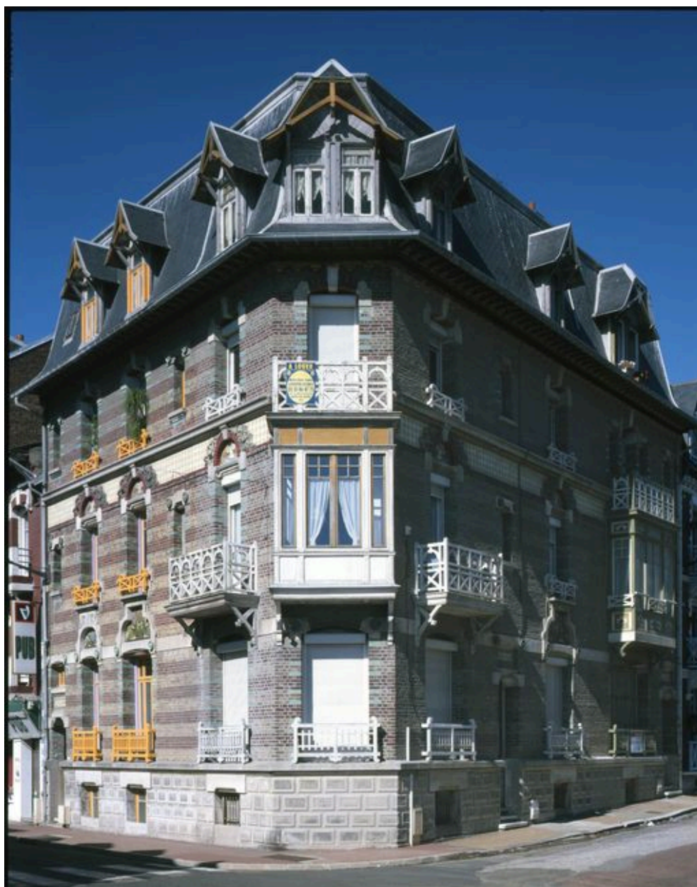
Vue d'ensemble, en cours de rénovation en 2004.
