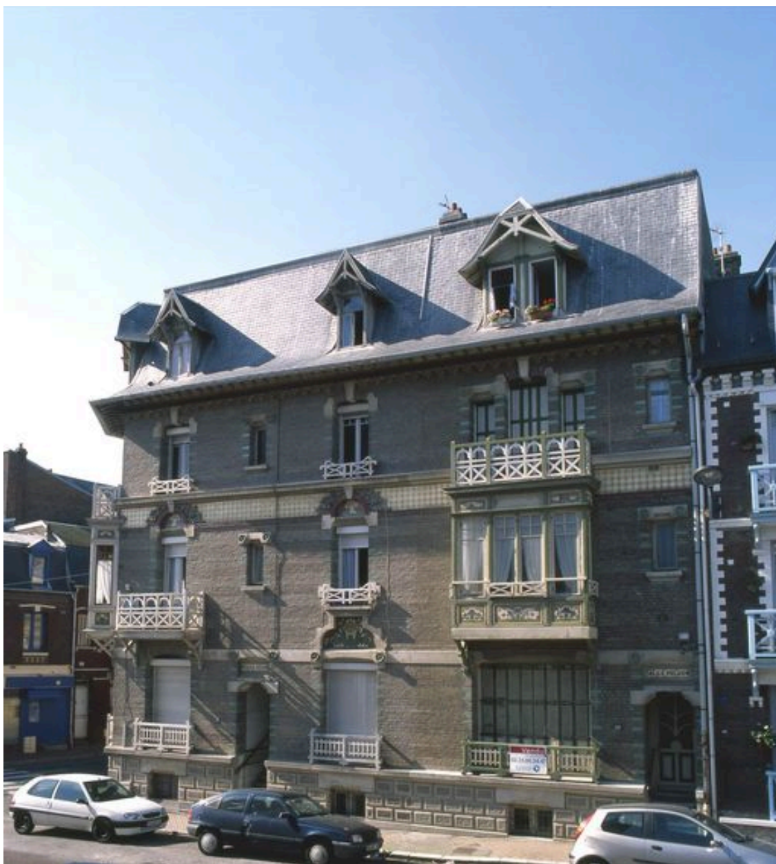
Vue d'ensemble sur la rue Duquesne.
