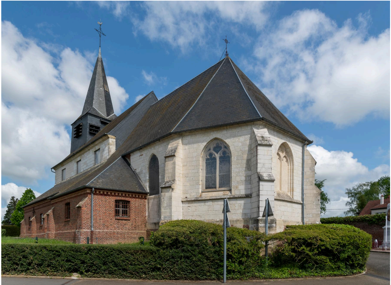
Vue générale depuis le sud-ouest.
