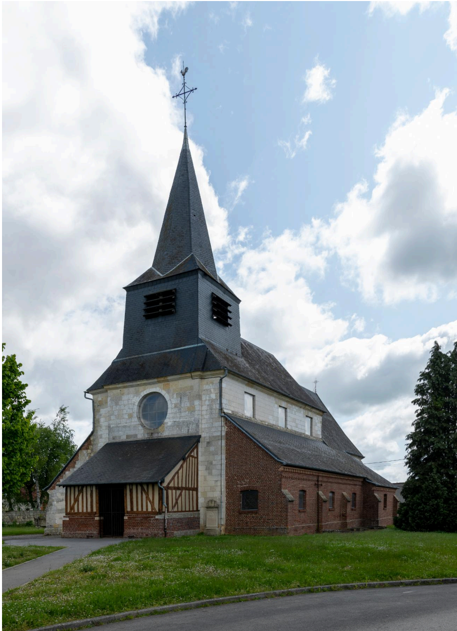
Vue générale depuis le sud-ouest.
