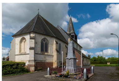
Vue générale du chevet et du monument aux morts depuis le nord-est. Phot. Marc Kérignard IVR32_20236000633NUCA
