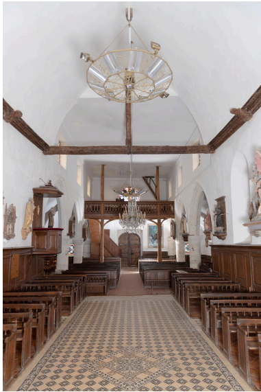
Vue générale vers la nef. Phot. Marc Kérignard IVR32_20226001053NUCA
