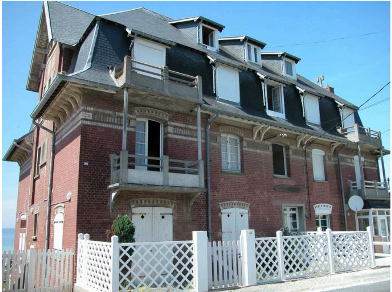
Elévation postérieure avec la plaque émaillée portant inscription eau de source, à gauche.
