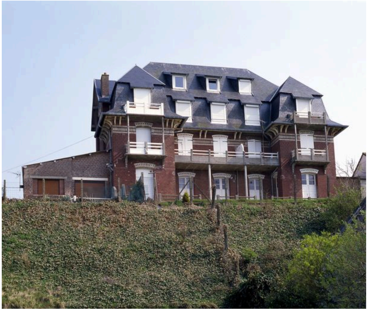
Vue d'ensemble, façade sur mer.
