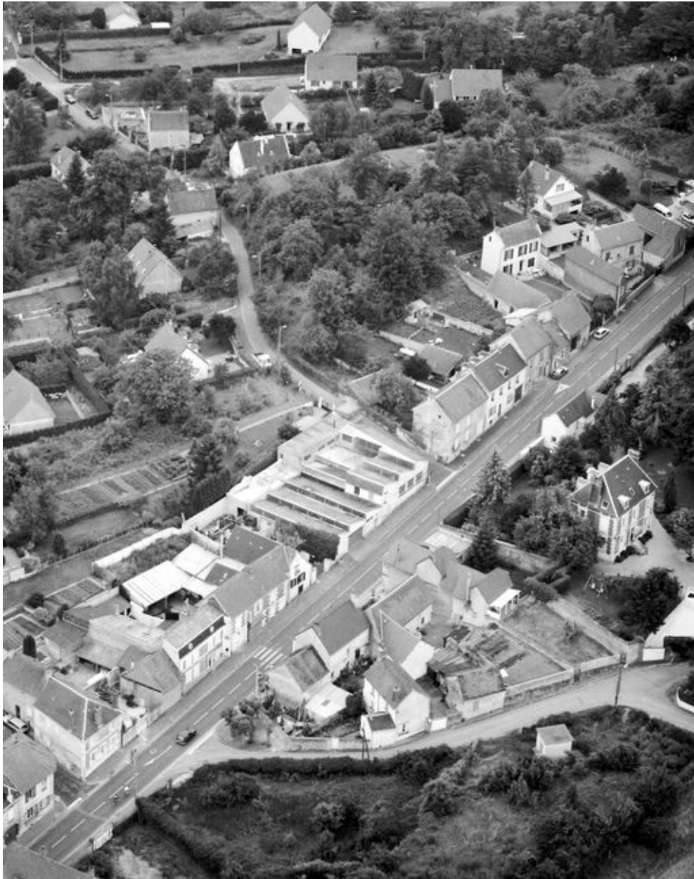
Vue aérienne de l'usine en 1994.
