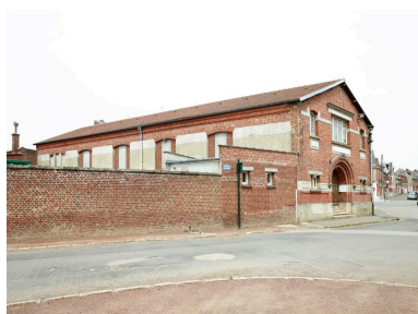
Vue de la façade latérale gauche. Phot. Delphine Volto-Jourdan IVR32_20216200591NUCA
