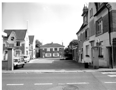
Vue générale des logements ouvriers. Phot. Laurent Jumel IVR22_19966002652X
