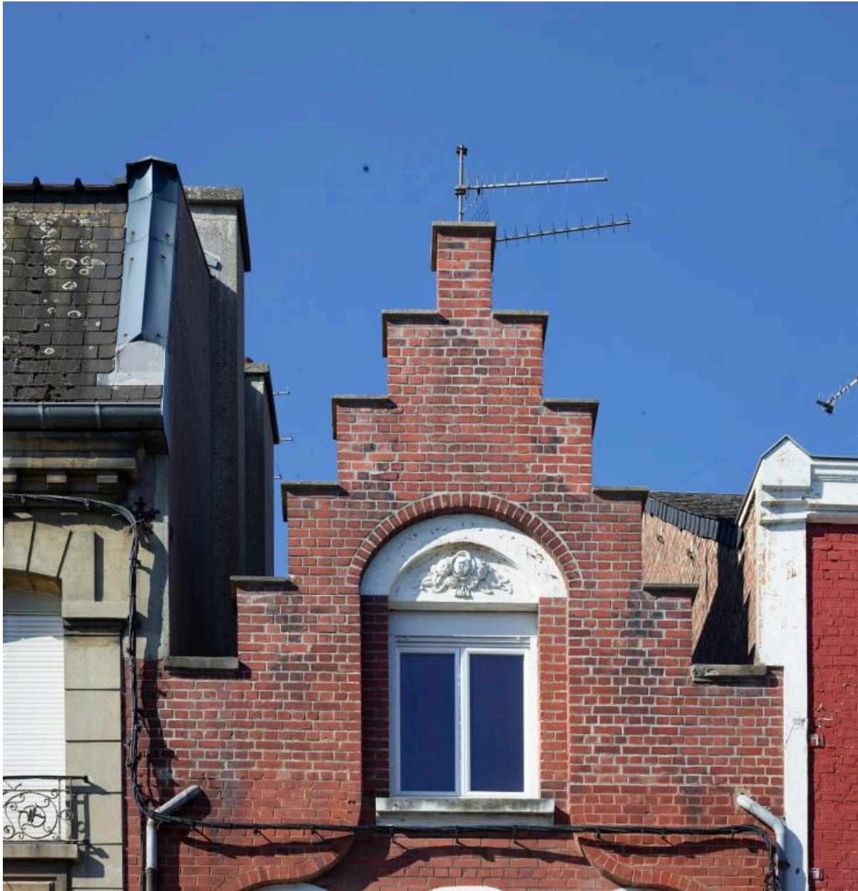
Détail du pignon à redents.
