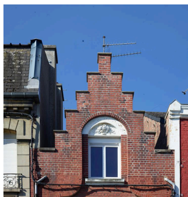
Détail du pignon à redents. Phot. Hubert Bouvet IVR32_20196200619NUC4A
