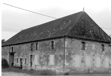
Vue depuis le nord-est. Phot. Xavier-Philippe Guiochon IVR22_19980201620Z
