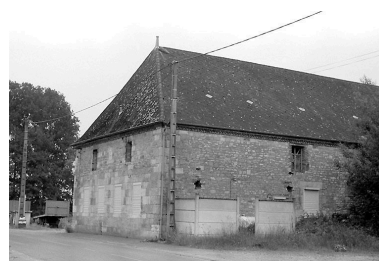
Vue depuis le nord-ouest. Phot. Xavier-Philippe Guiochon IVR22_19980201619Z
