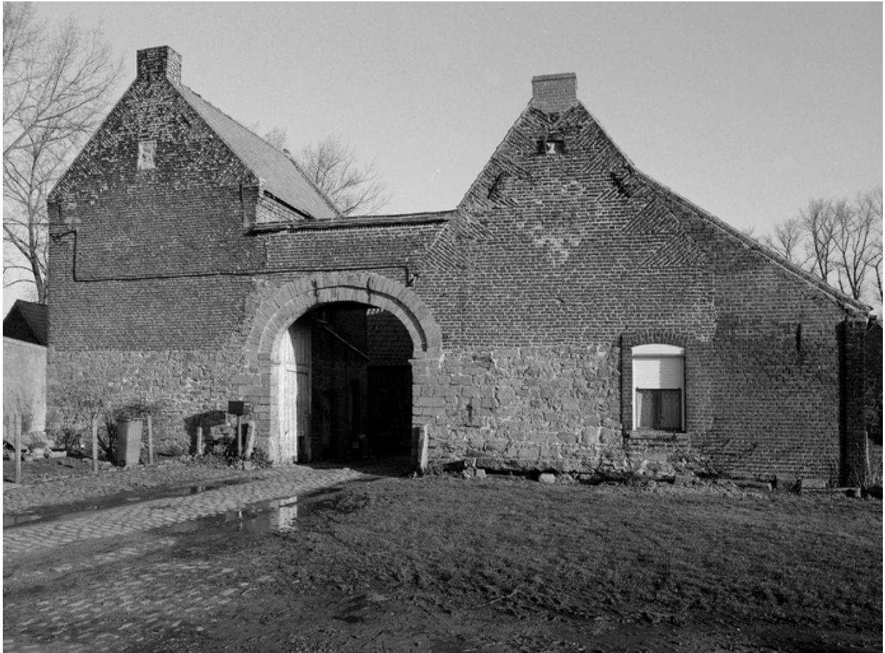
Entrée principale et porche.
