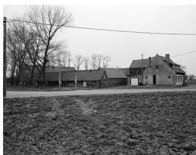
Vue générale de trois quarts, les étables-écuries au premier plan. Phot. Philippe Dapvril IVR31_20055900487X
