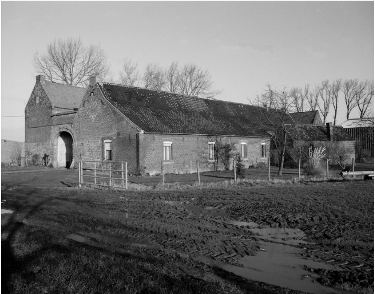
Vue générale de trois quarts, le logis au premier plan.
