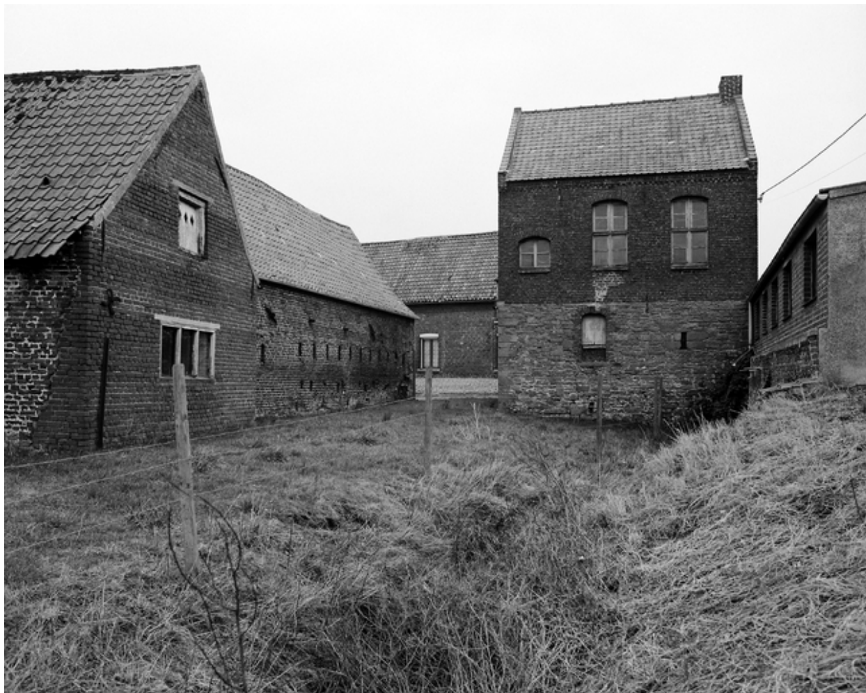
Elévations du bâtiment dit Playdoyable et étables depuis la rue.
