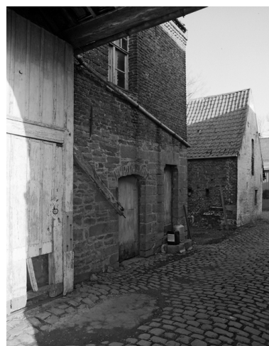
Elévation du bâtiment dit Playdoyable depuis le porche. Phot. Philippe Dapvril IVR31_20055900159X
