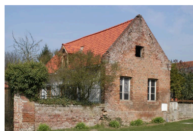
Dépendance, au nord de la parcelle. Phot. Thierry Lefébure IVR22_20038000261NUCA
