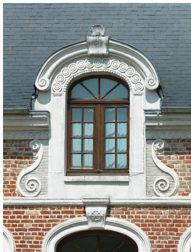
Détail de la lucarne de toit. Phot. Thierry Lefébure IVR22_20128000306NUC2A
