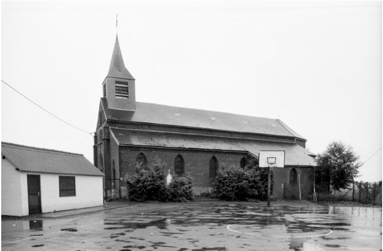
Vue d'ensemble de l'élévation sud.
