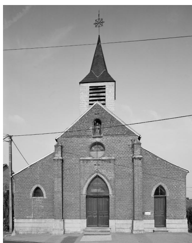
Vue d'ensemble de la façade. Phot. Thierry Lefébure IVR22_19910201286V
