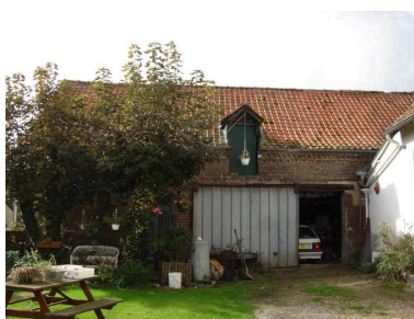
Vue de ces dernières depuis la cour. Phot. Inès Guérin IVR22_20068005513NUCA
