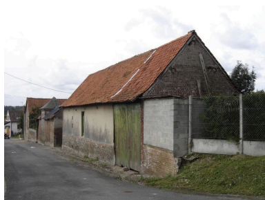
Vue générale depuis la rue. Phot. Inès Guérin IVR22_20068005509NUCA
