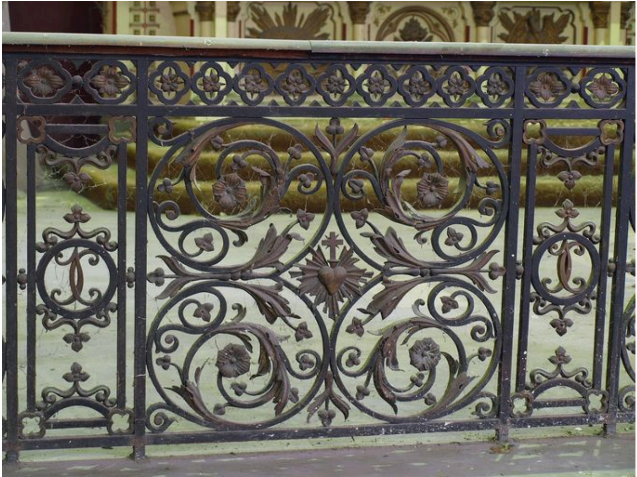
Vue de détail
