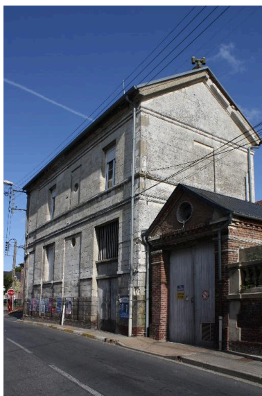
Vue d'ensemble depuis la rue du Maréchal-Leclerc et de la 2e DB. Phot. Bertrand Fournier IVR22_20138016057NUC2A
