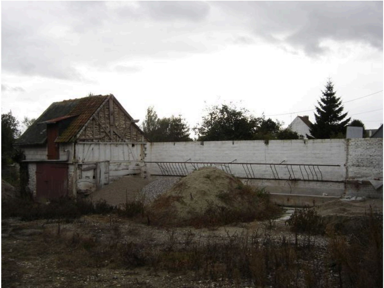
Vue des dépendances et des écuries en ruine.
