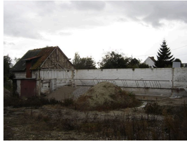
Vue des dépendances et des écuries en ruine. Phot. Inès Guérin IVR22_20078005305NUCA
