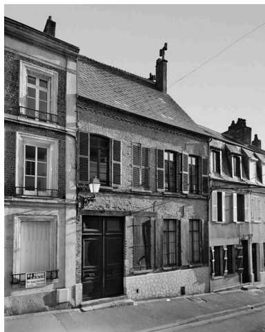
Vue de la façade sur rue. Phot. Thierry Lefébure IVR22_19990205982V
