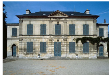
Elévation antérieure. Phot. Jean-Michel Perrin IVR22_19856000715XA
