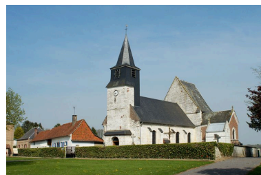
Vue générale depuis le sud-ouest. Phot. Marie-Laure Monnehay-Vulliet IVR22_20118000068NUCA
