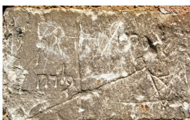
Graffiti portant les dates de 1770 et 1779, au chevet de l'église. Phot. Frédéric Fournis IVR22_20108001960NUCA
