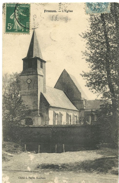
La mare communale et l'église, avant 1914 (coll. part.). Phot. Monnehay-Vulliet Marie-Laure IVR22_20108000197NUCA
