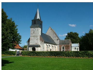
Vue générale depuis l'ouest. Phot. Frédéric Fournis IVR22_20088015112NUCA
