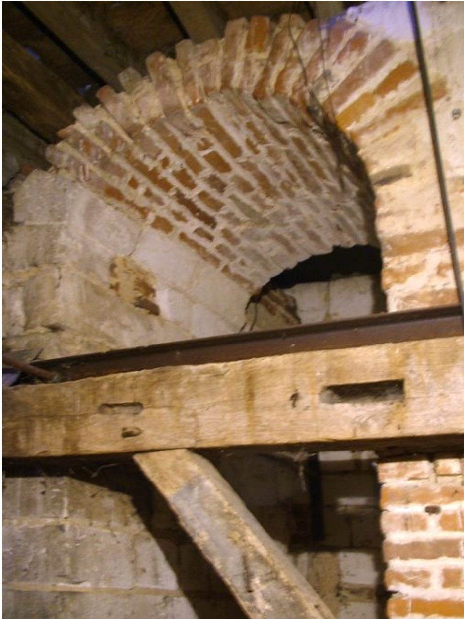
Baie sud de l'ancien clocher-mur.
