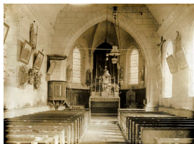
Vue intérieure, vers 1920 (archives privées). Phot. Monnehay-Vulliet Marie-Laure IVR22_20118000140NUCA
