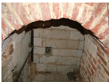
Partie supérieure de la baie sud de l'ancien clocher-mur. Phot. Frédéric Fournis IVR22_20108001957NUCA
