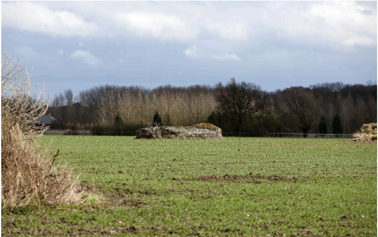
Casemate nord, vers l'est
