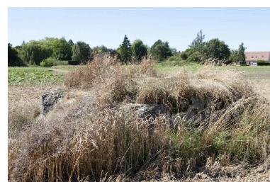
Casemate sud, vers l'ouest Phot. Pierre Thibaut IVR32_20166200353NUCA
