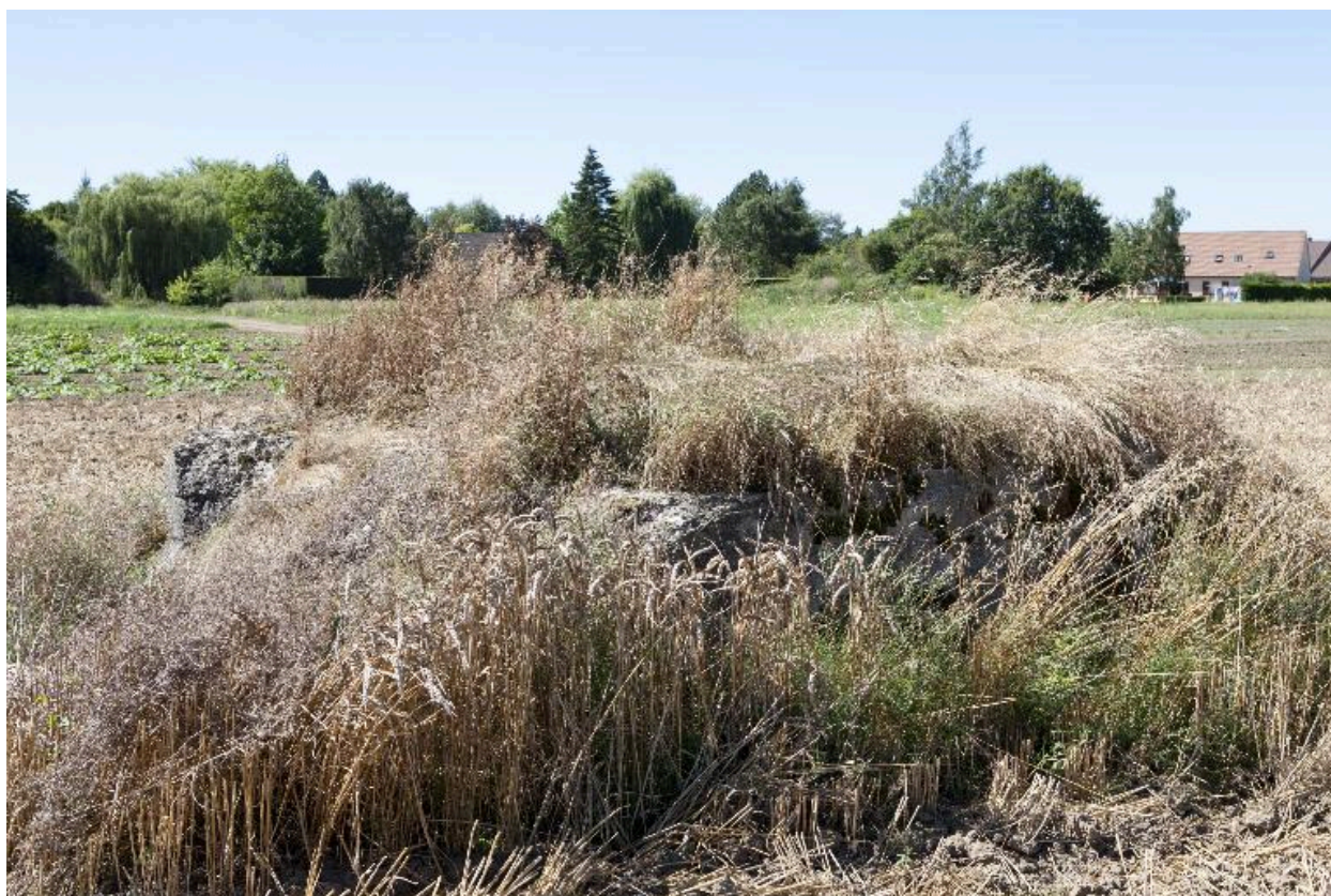
Casemate sud, vers l'ouest
