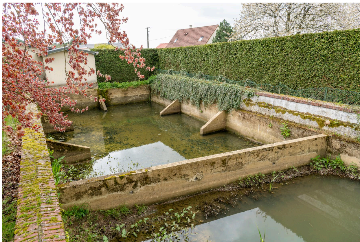
Mare au nord de la rue des Charrons, vue prise depuis l'est.
