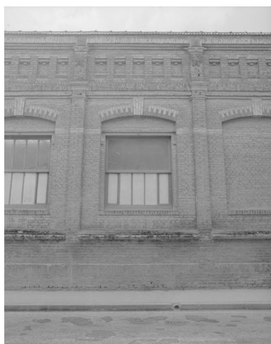
Atelier de fabrication, élévation antérieure. Phot. Thierry Lefébure IVR22_19898000277X
