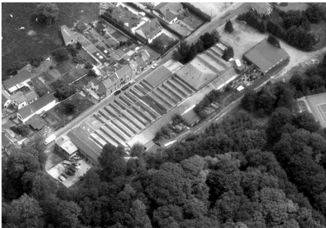
Vue aérienne depuis le nord.
