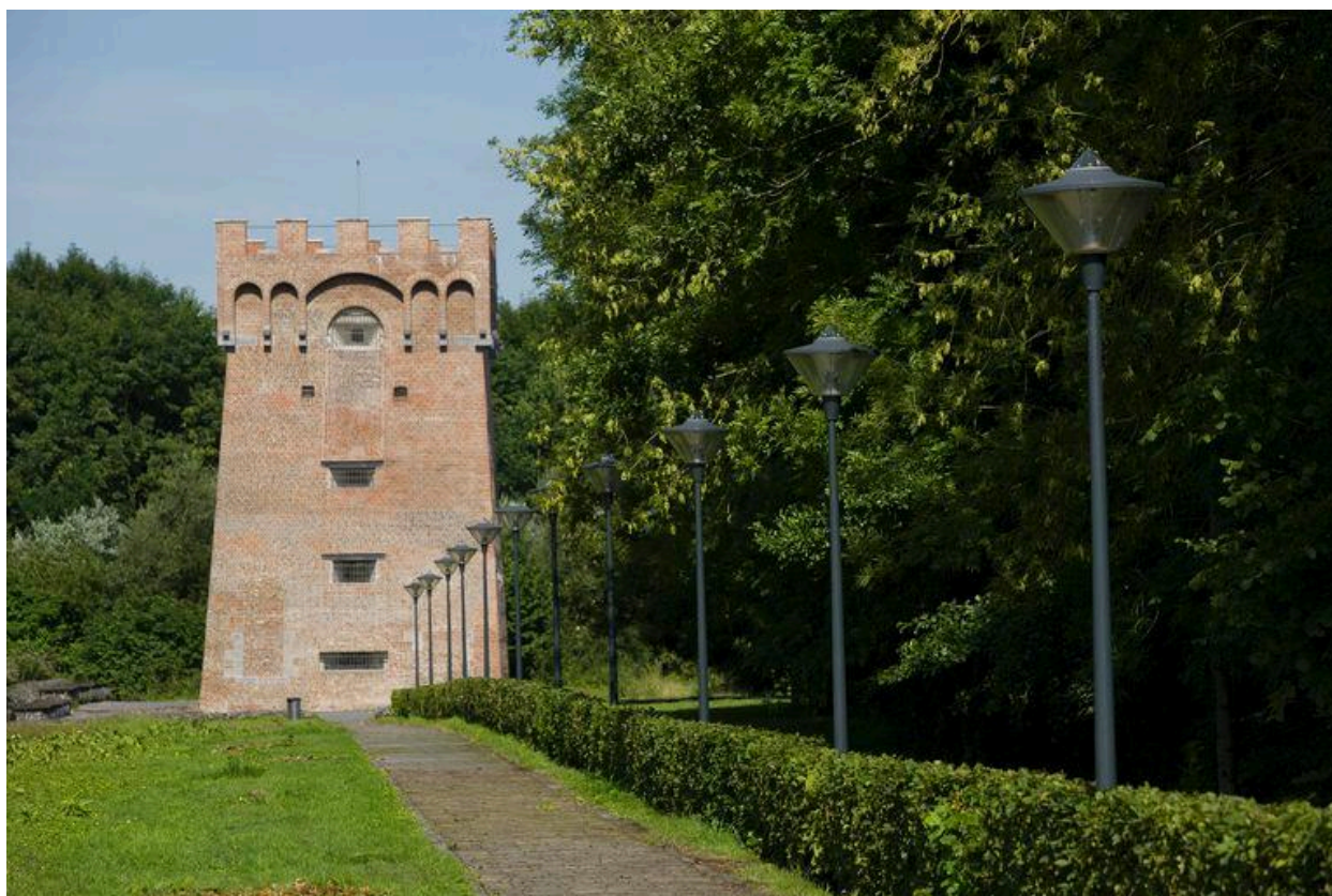
Chevalement du puits 1 de la fosse Sarteau, protégée au titre des Monuments Historiques.
