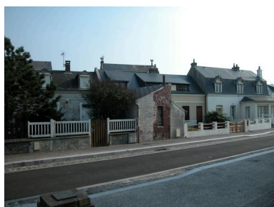
Façade postérieures sur la rue Joffre des maisons de la rue Duquesne. Phot. Elisabeth Justome IVR22_20058003654NUCA
