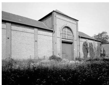
Entrepôt industriel (groupe 1), en 1989 : flanc est. Phot. Thierry Lefébure
