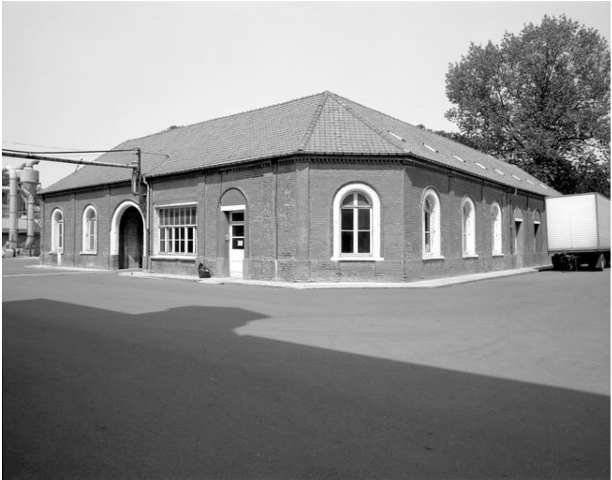
Edifice industriel (dépôt divers, anciennement bureau), en 1989 : élévation sud-est.
