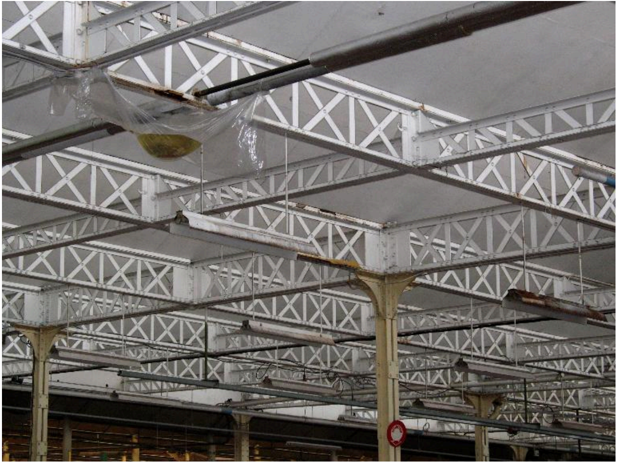
Détail de la charpente métallique étré sillonnée du tissage de jute.
