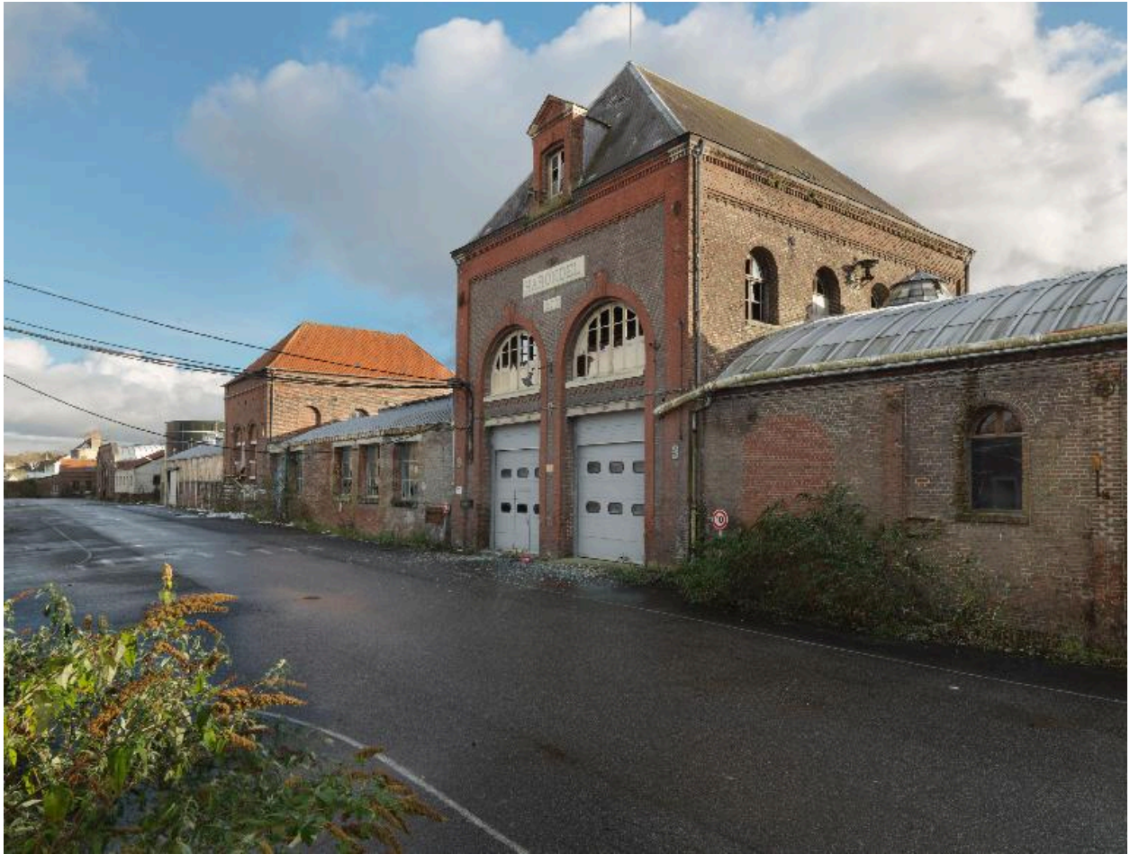
Entrée monumentale de la filature flanquée des magasins à fils aux toits bombés.
