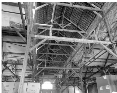
Magasin industriel, en 1989 : vue intérieure (charpente). Phot. Thierry Lefébure IVR22_19898000233X
