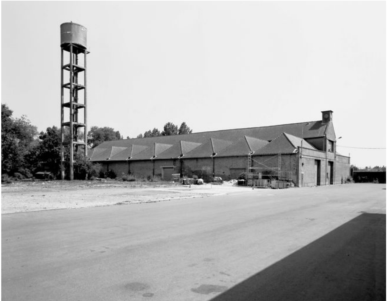
Entrepôt industriel (groupe 2), château d'eau, en 1989 : vue générale sud-ouest.
