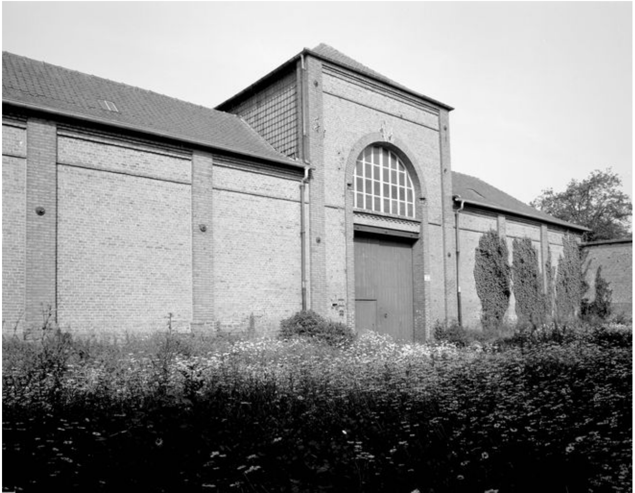
Entrepôt industriel (groupe 1), en 1989 : flanc est.
