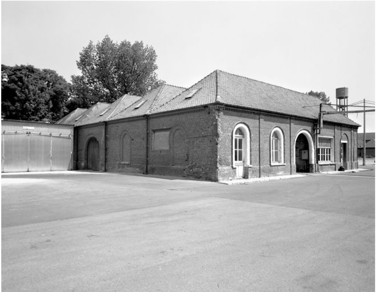
Edifice industriel (dépôt divers), en 1989 : élévation sud-ouest.
