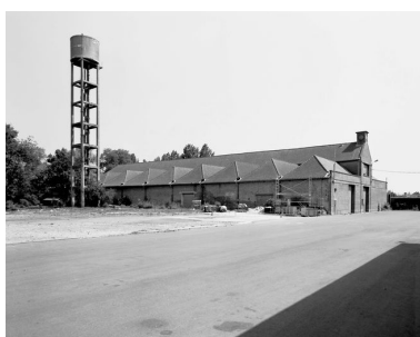
Entrepôt industriel (groupe 2), château d'eau, en 1989 : vue générale sud-ouest. Phot. Thierry Lefébure IVR22_19898000217X
