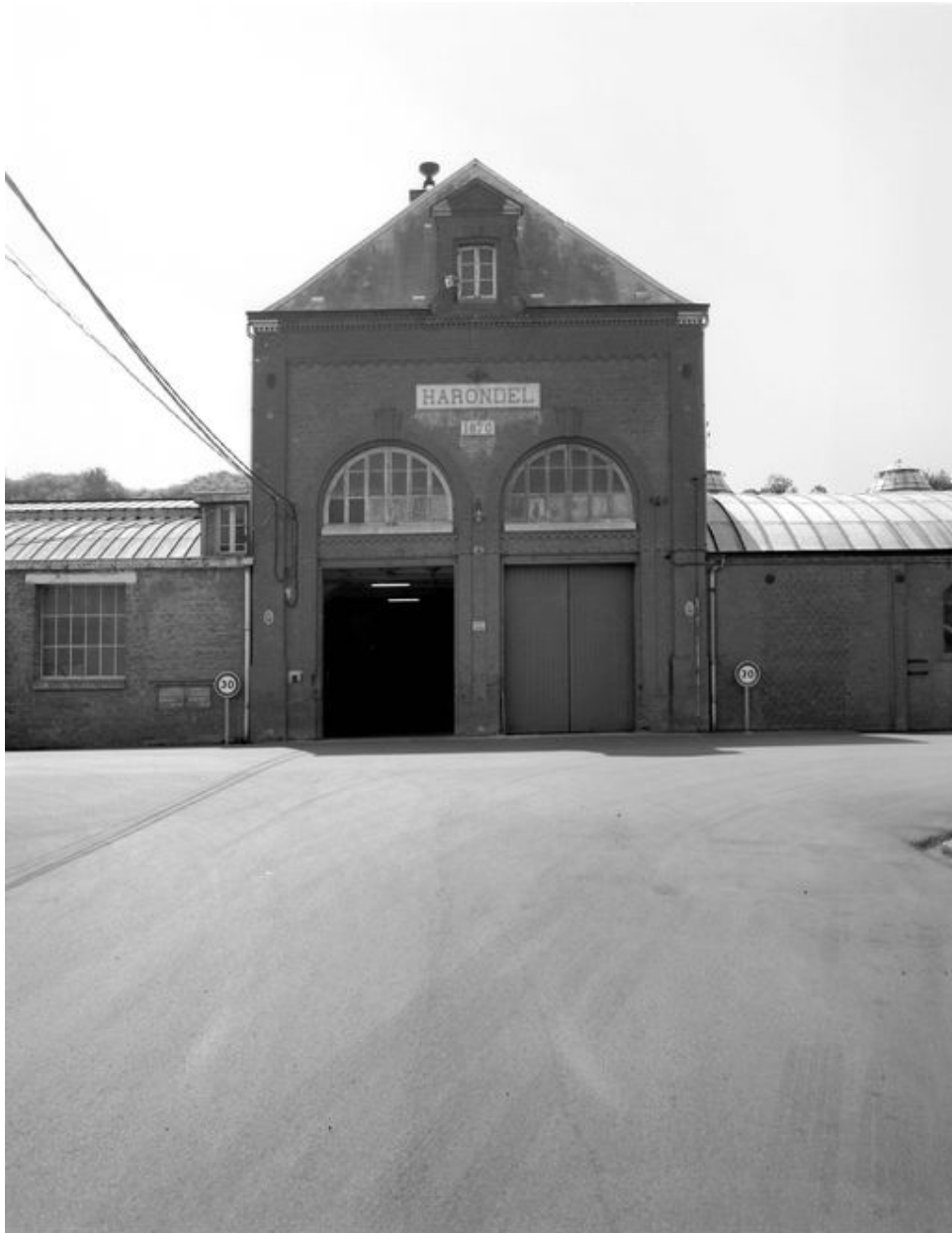
Entrée principale des ateliers de fabrication, en 1989 : élévation nord.
