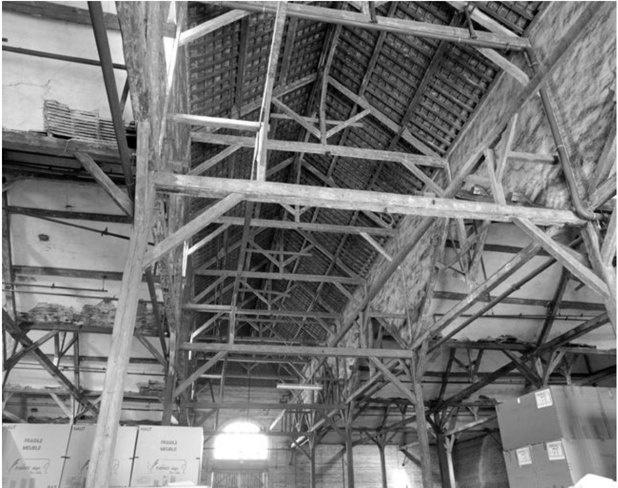
Magasin industriel, en 1989 : vue intérieure (charpente).
