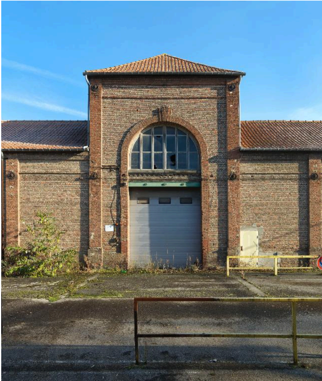
Porche d'entrée du grand entrepôt à jute.
