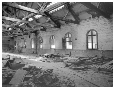
Scierie, en 1989 : vue intérieure. Phot. Thierry Lefébure IVR22_19898000208X
