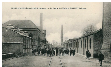
Vue d'ensemble de l'usine à l'heure de la sortie, vers 1910 (coll. part.). Phot. Fournier Bertrand (reproduction) IVR22_20088015061NUCA
