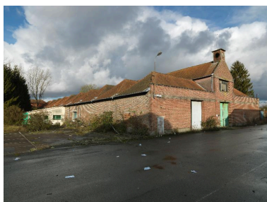
Les seconds entrepôts à jute, vue d'ensemble extérieure depuis l'ouest. Phot. Thierry Lefébure IVR22_20128001267NUC2A
