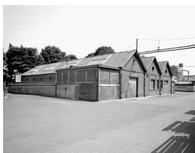
Edifice industriel (dépôt, études), en 1989 : élévation sud-ouest. Phot. Thierry Lefébure IVR22_19898000212X
