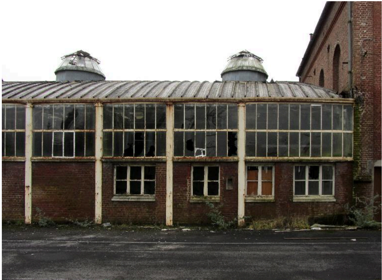
Vue partielle de la façade d'un des magasins à fils.
