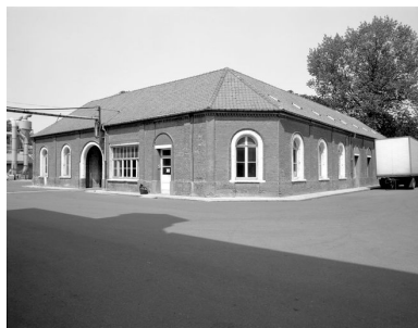
Edifice industriel (dépôt divers, anciennement bureau), en 1989 : élévation sud-est. Phot. Thierry Lefébure IVR22_19898000215X
