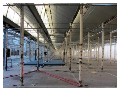
Vue intérieure de l'atelier de filature avec supports de section circulaire. Phot. Bertrand Fournier
