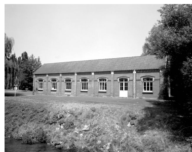
Bureau (anciennement crèche), en 1989 : flanc sud. Phot. Thierry Lefébure
