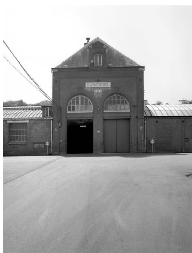
Entrée principale des ateliers de fabrication, en 1989 : élévation nord. Phot. Thierry Lefébure IVR22_19898000221X
