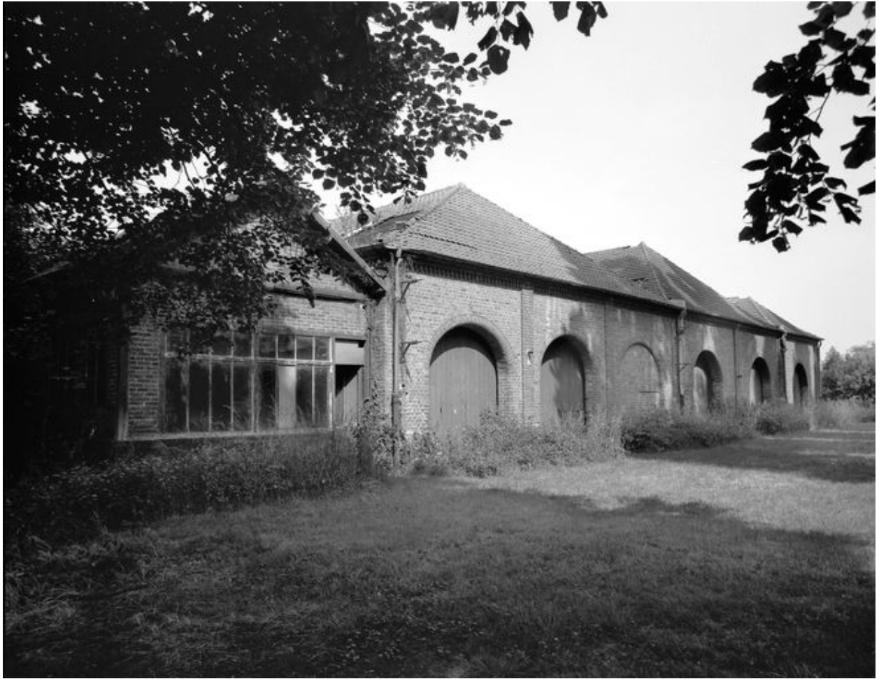
Scierie, en 1989 : élévation est.
