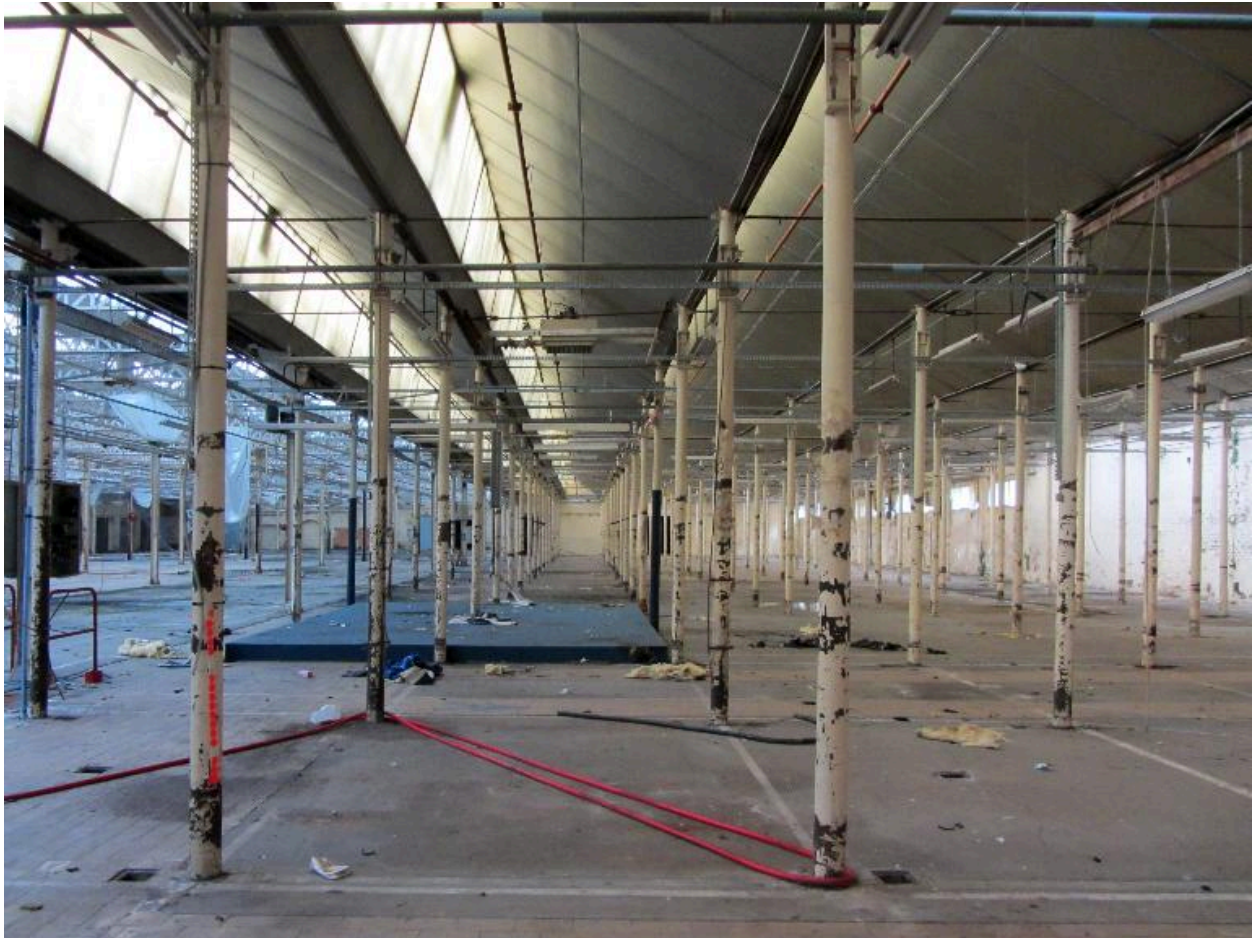
Vue intérieure de l'atelier de filature avec supports de section circulaire.
