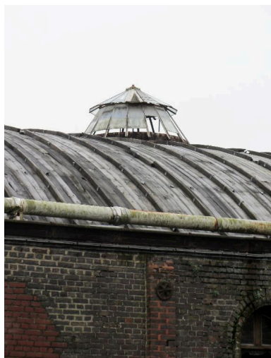
Détail d'un lanterneau en verre au-dessus d'un puits de lumière. Phot. Bertrand Fournier IVR22_20138016189NUC2A
