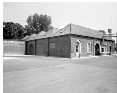
Edifice industriel (dépôt divers), en 1989 : élévation sud-ouest. Phot. Thierry Lefébure IVR22_19898000219X
