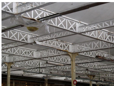
Détail de la charpente métallique étré sillonnée du tissage de jute. Phot. Bertrand Fournier IVR22_20138016188NUC2A
