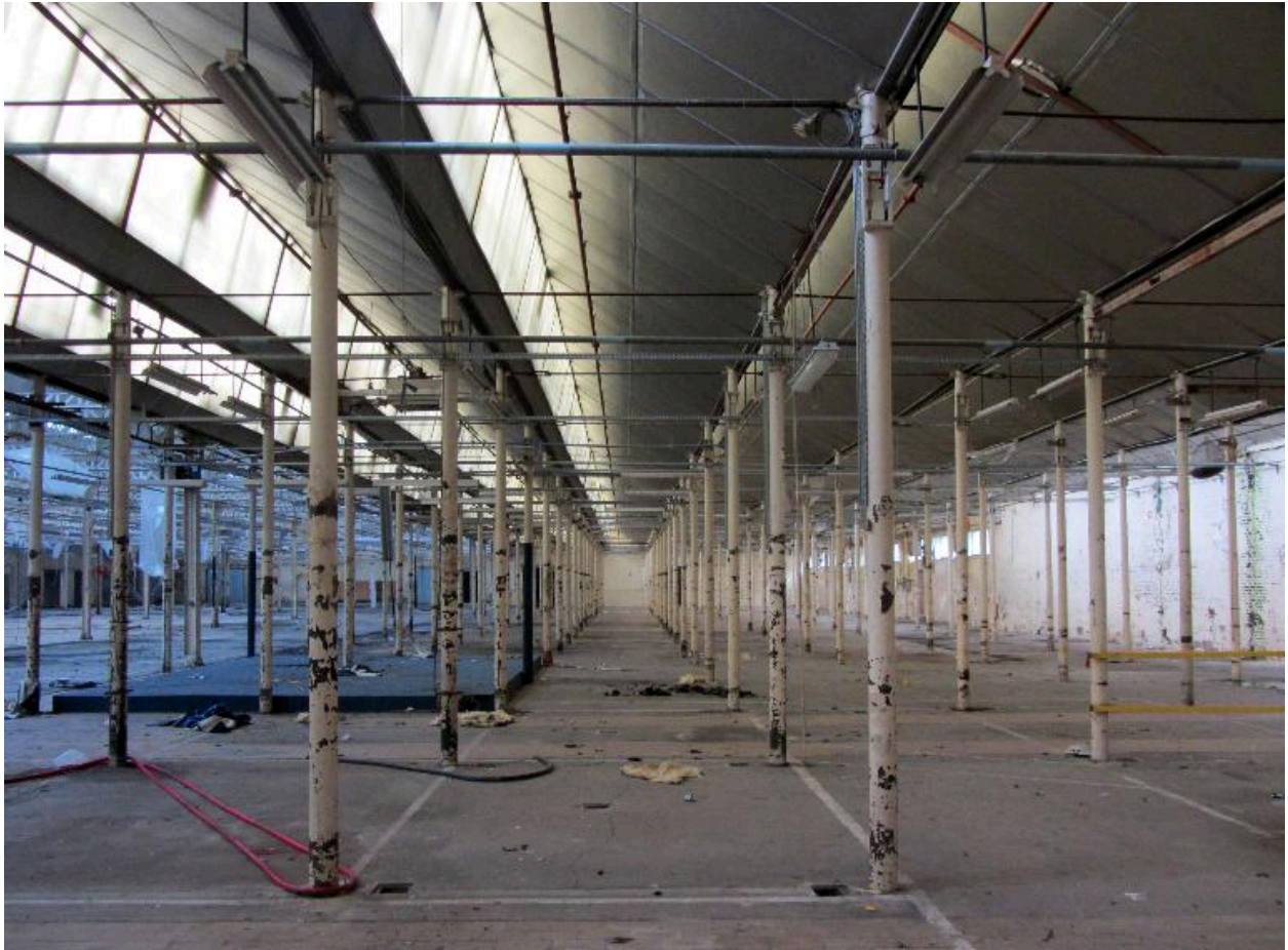
Vue intérieure de l'atelier de filature de jute, avec supports de section circulaire.
