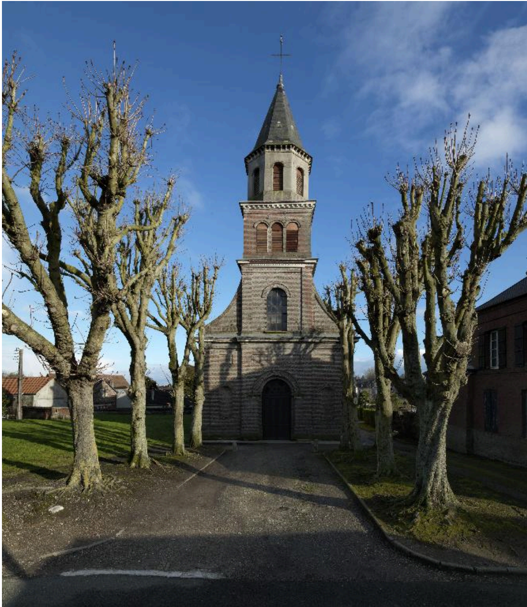
Vue depuis le nord.
