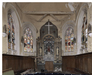
Vue du chœur. Phot. Thierry Lefébure IVR22_20158000040NUC2A
