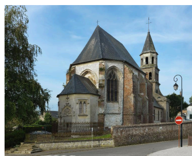
Vue de trois-quarts depuis la place Adéodat-Gilson. Phot. Thierry Lefébure IVR22_20148000506NUC2A
