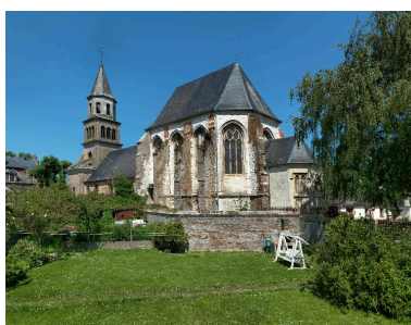
Vue de trois-quarts depuis la rue Émile-Zola. Phot. Thierry Lefébure IVR22_20148000407NUC2A
