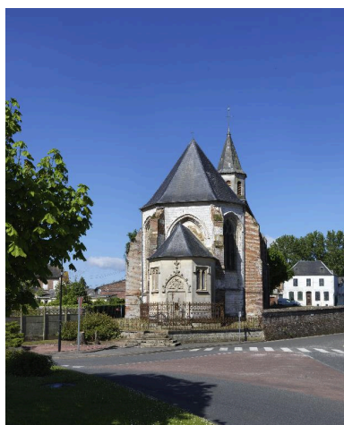
Vue du chevet. Phot. Thierry Lefébure IVR22_20158000380NUC2A
