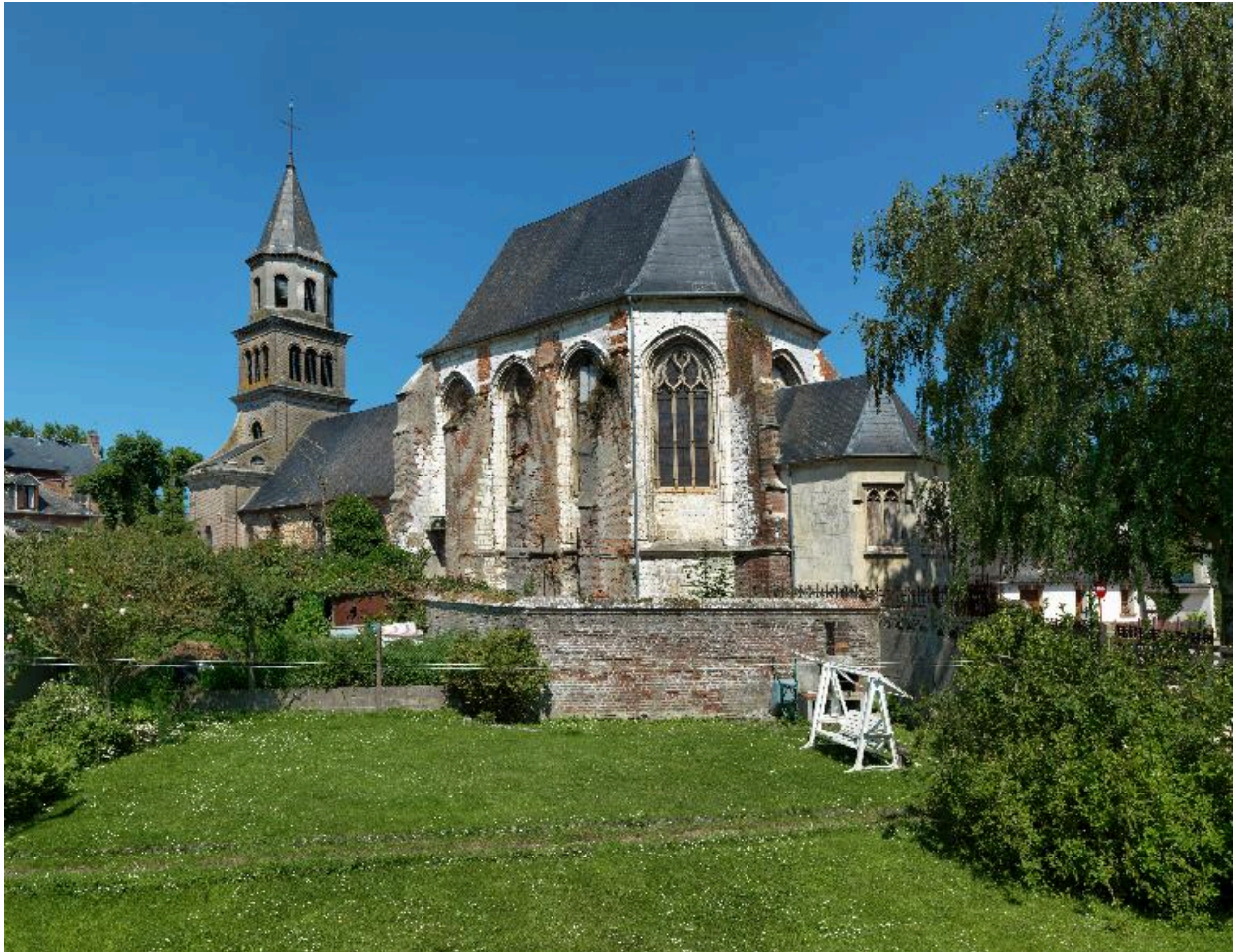
Vue de trois-quarts depuis la rue Émile-Zola.
