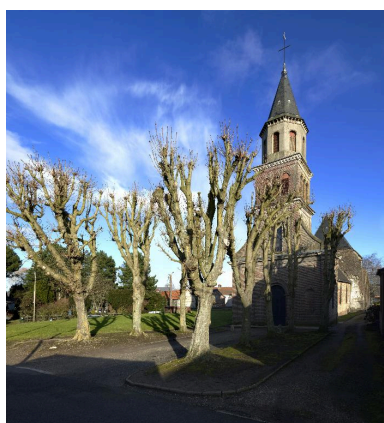
Vue depuis le nord-ouest. Phot. Thierry Lefébure IVR22_20158000037NUC2AQ
