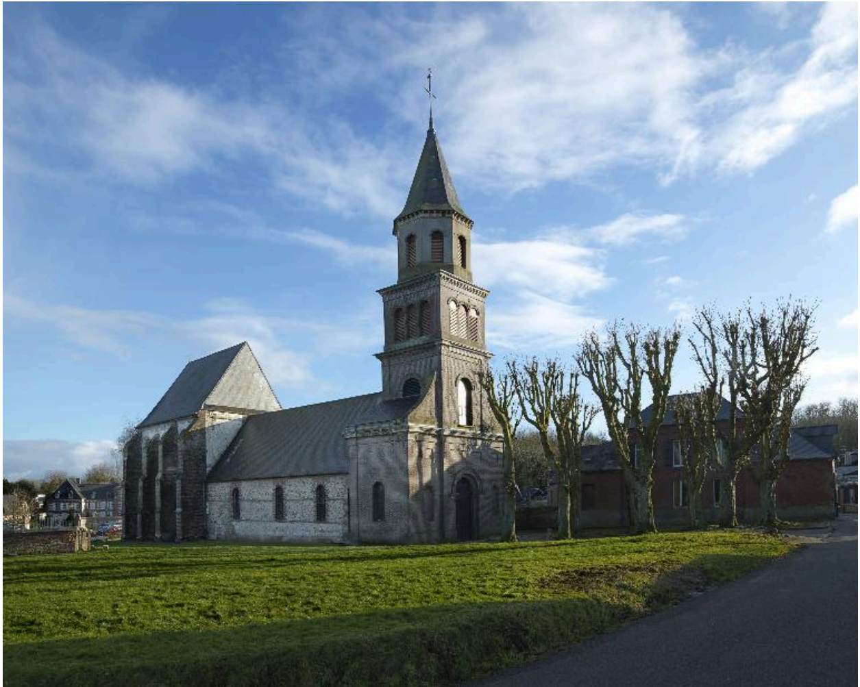
Vue depuis le nord-est.
