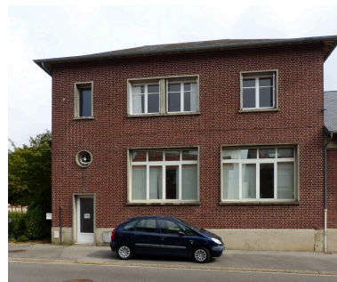
Le pavillon à étage (rue Fernand-Bouyssou). Phot. Isabelle Barbedor IVR32_20210205124NUCA
