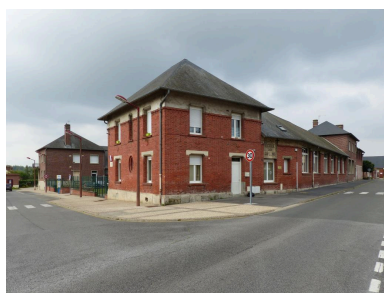
Les bâtiments de l'ancienne école de garçons. Phot. Isabelle Barbedor IVR32_20210205120NUCA
